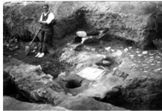
Figura 224. Embornal de la Via Augusta, al Clos de la Torre, durant la seva excavació (PADRÓS, SÁNCHEZ 2011: 226)
