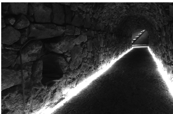
Figura 165. Conducte d'aigües del C. Pujol, amb una de les seves escomeses secundàries (N. Romani)
