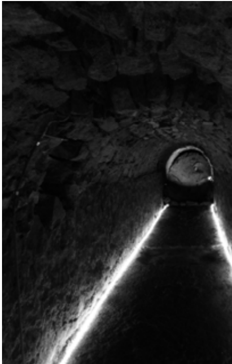
Figura 227. (a l'esquerra) Conducte del C. Pujol, amb una de les escomeses secundàries, a la dreta, en primer terme, i un orifici zenital de registre (N. Romani)
