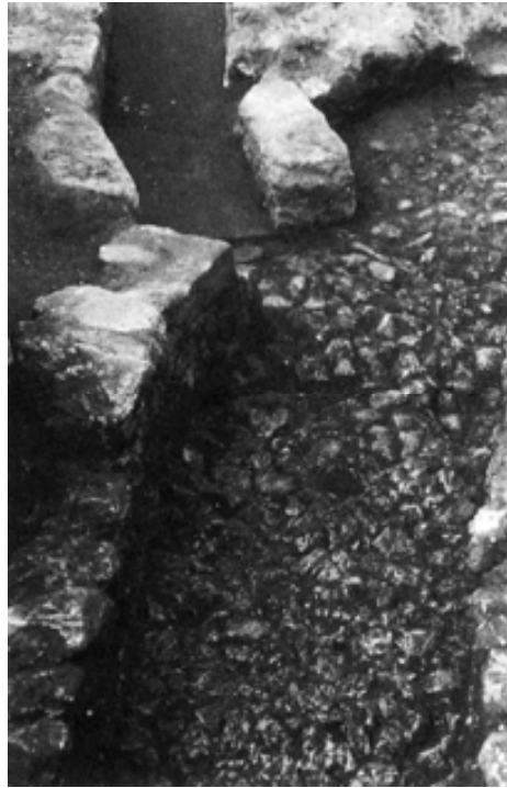
Figura 196. Solera de la claveguera 2 de Fluvià 12-16, i el seu punt de connexió amb la claveguera 1 (PADRÓS 1999a: 619)
