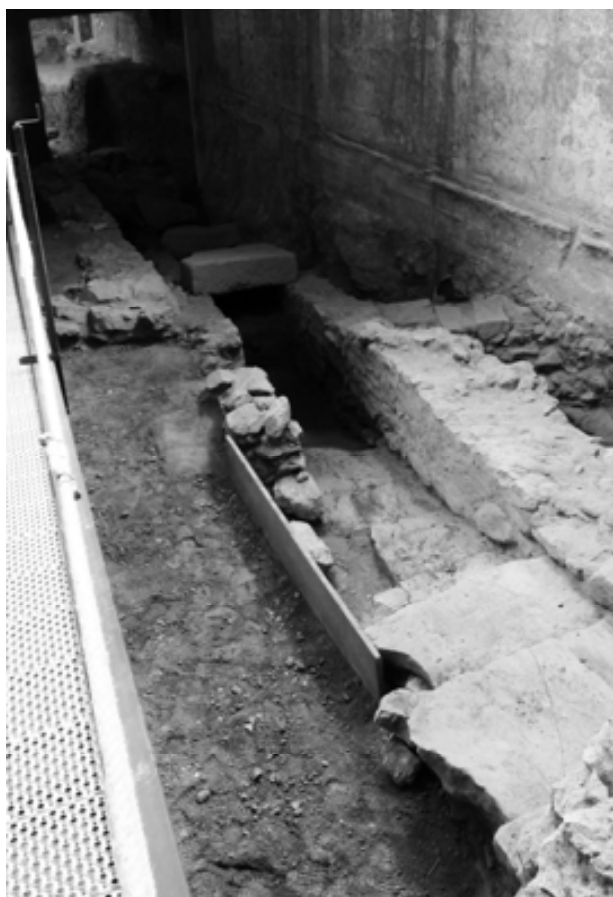
Figura 222. Gran col·lector del cardo maximus , tram 11, amb la solera esglaonada com a sistema de reducció de la velocitat del corrent hídric (N. Romani)
