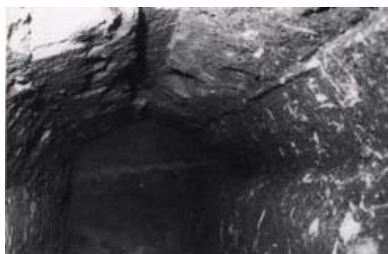
Figura 145. Interior del col·lector del cardo maximus , en aquest tram feta amb un encofrat d' opus caementicium (CERDÀ et alii. 1997: 241)
