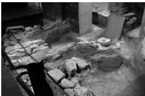
Figura 177 (a baix). Detall del col·lector central del cardo , des del NO, amb diverses escomeses secundàries, una d'elles amb una teula per recollir les aigües de la teulada i un embornal circular que les conduïa dins la canal (N. Romani)
