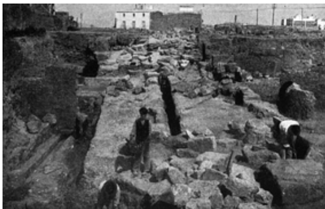
Figura 301. (a baix) Imatge de les excavacions dels anys 20 al decumanus , des del SE, on es pot veure el fort desmuntatge de l'enllosat del carrer d'època antiga (SERRA VILARÓ 1932: fig. 26)
