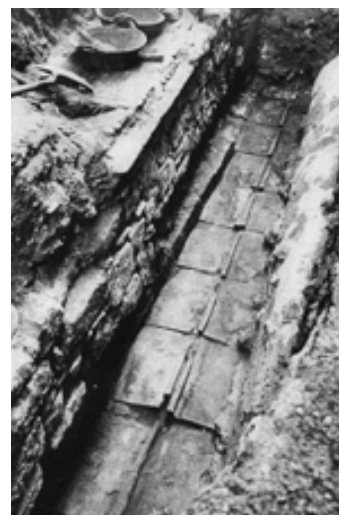
Figura 248. Imatge dels anys 60 del col·lector del cardo màxim (BELTRÁN DE HEREDIA, CARRERAS 2011: 235)
