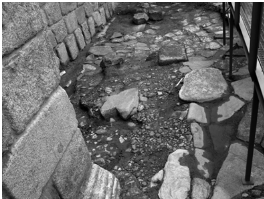
Figura 402. Reparacions puntuals de desgast i enfonsaments de l'enllosat, a partir de petites aportacions de terra i grava molt compactades, a l'entorn de la porta d'accés de La Alcazaba (N. Romani)
