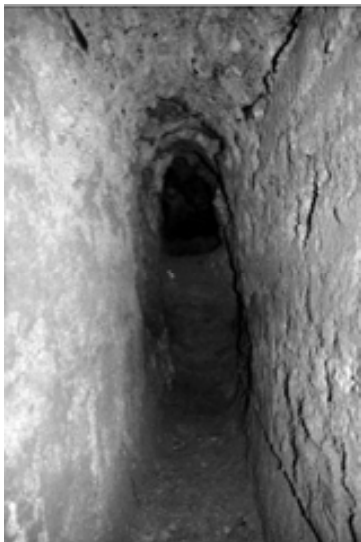
Figura 316. Una secció del cuniculus de Tarraco, un dels sistemes d'aprovisionament d'aigua de la ciutat republicana (MACIAS et alii . 2007a: 122)
