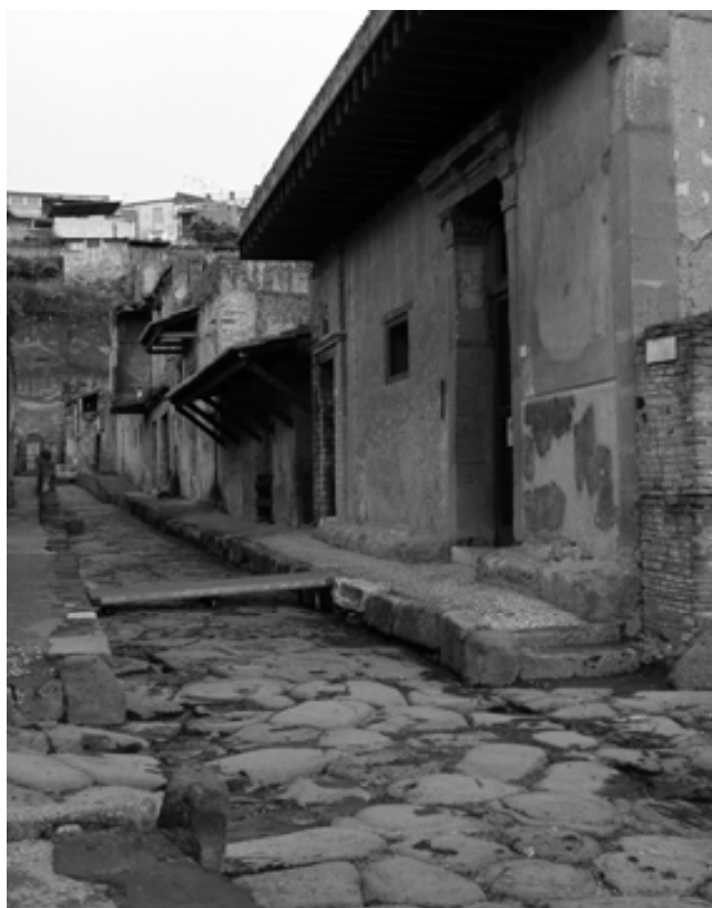
Figura 406. Casa sannitica d'Herculà, amb la vorera particular, pavimentada amb opus barbaricum i dotada d'uns bancs laterals d'espera (J. Acero)
