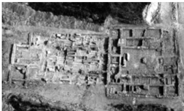
Figura 291. (a baix) Vista aèria de la basílica septentrional construïda al suburbi occidental de Tarraco els s. IV-V dC (LÓPEZ 2006)
