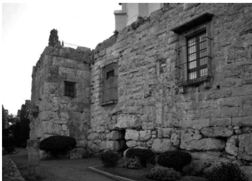
Figura 282. Muralles de Tarraco, a l'actual Passeig arqueològic, amb una de les torres i un poterna d'accés (R. Ballo)
