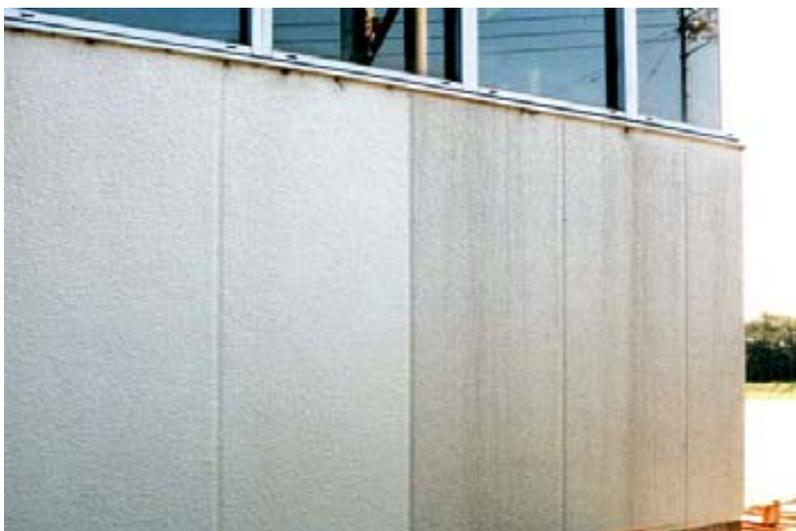
Figura 1.5: Comparación efectuada entre dos tipos de recubrimientos: a la izquierda recubrimiento con  $\text{TiO}_2$ , a la derecha, recubrimiento sin  $\text{TiO}_2$
