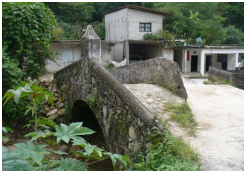
Ilustración 10. Puente construido por la comunidad
