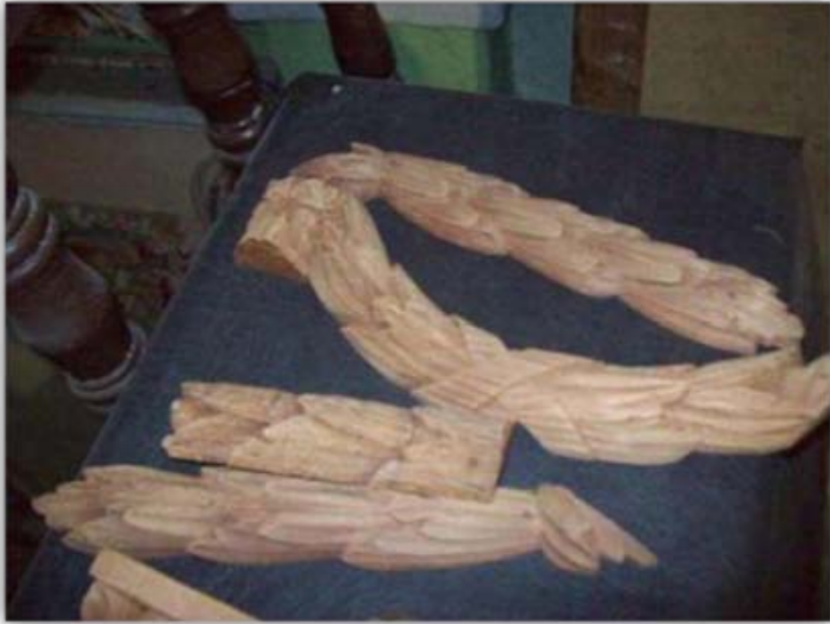
Restauración y limpieza de molduras y celosías.
