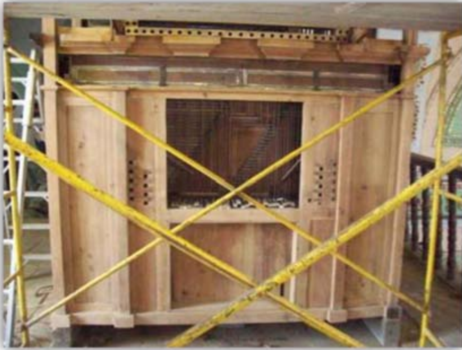
Caja inferior del órgano una vez realizada la limpieza y recuperación del acabado original.
