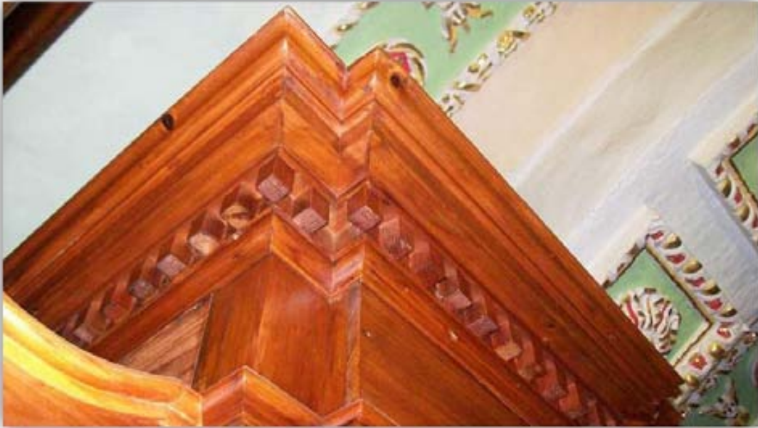
Detalle de las cornisas y restitución de elementos decorativos faltantes.
