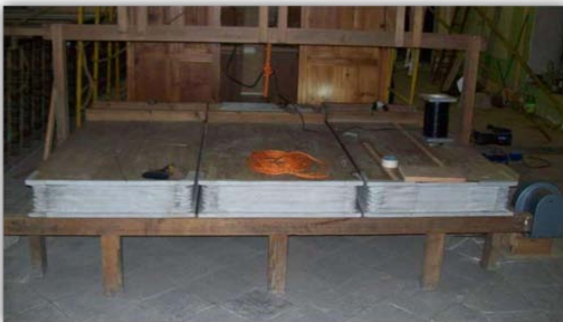
Colocación de los tres fueles originales ya restaurados.
