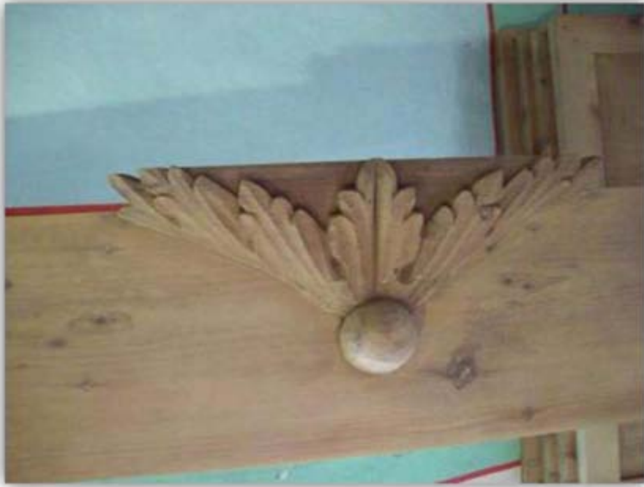
Restauración y limpieza de molduras.
