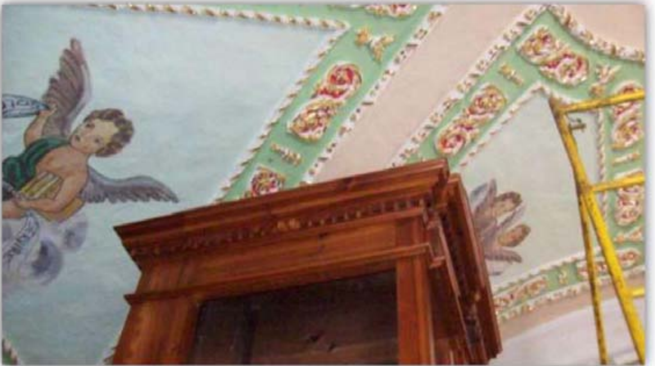
Restauración de celosías y caja.
