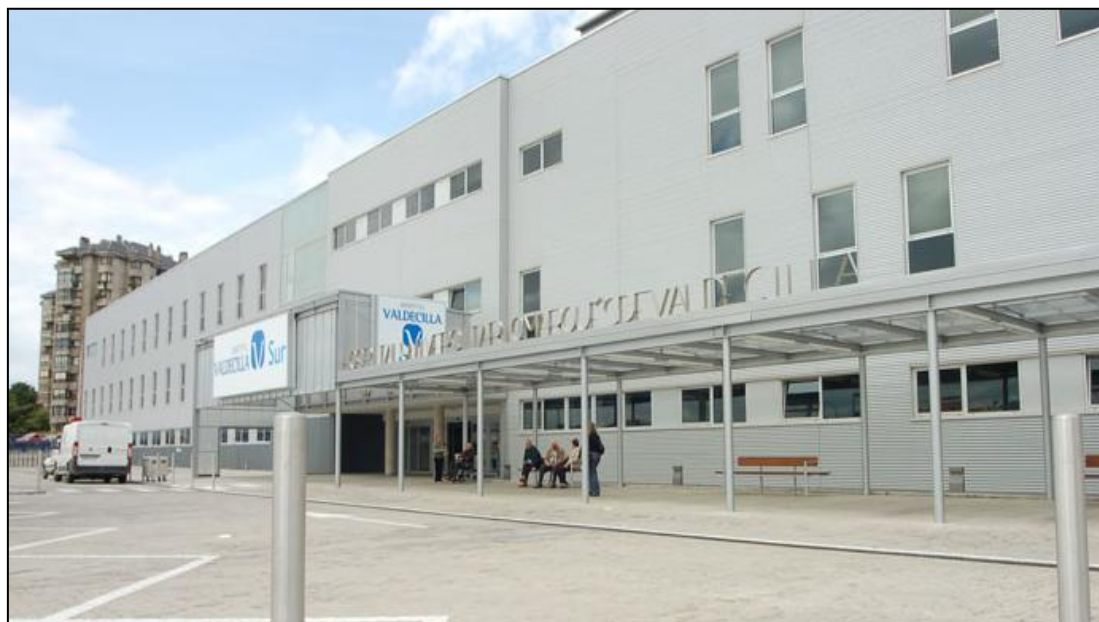
Imagen 3: Edificio Valdecilla Sur de Consultas Externas (HUMV)
