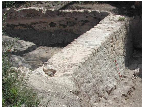
Figura 4.177. Mur de contenció de la Bassa del Clot des Guix (Autor: Mateu Riera)
