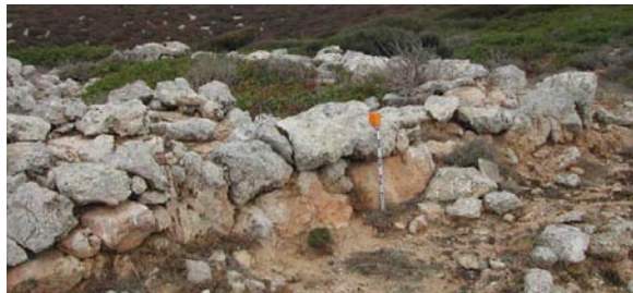
Figura 4.202. Façana SE de l'edifici Sud-est del jaciment dels Corral amb Cabrera al fons (Autor: Mateu Riera)
