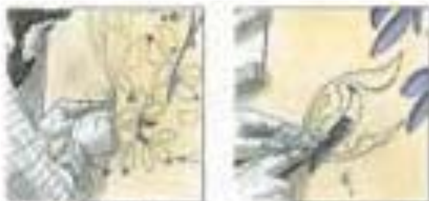
Figura 6. Ejemplo de la realización de un esgrafiado en fachada. El vaciado del recorte deja ver el color de la capa intermedia, en este caso de color violeta. Imagen del libro Guía práctica de la cal y el estuco 18 .
