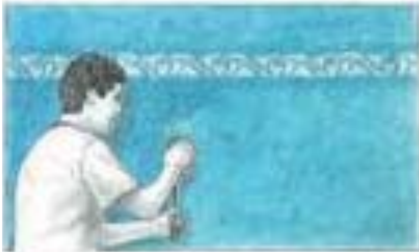
Figura 4. Confección de un estuco al fuego esgrafiado en la parte superior. Imagen del libro Guía práctica de la cal y el estuco 14 .
