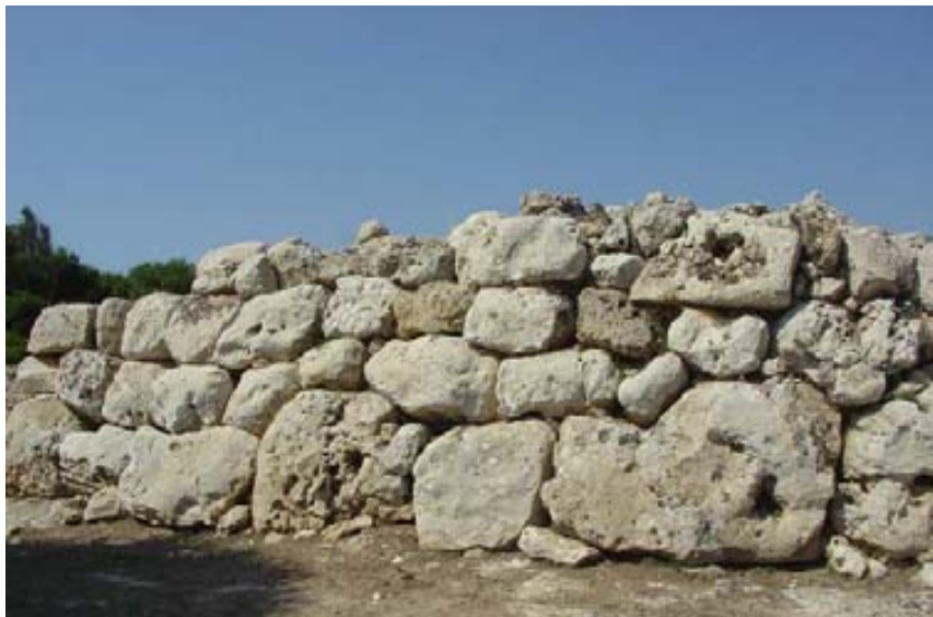
4. Paramento externo Este
