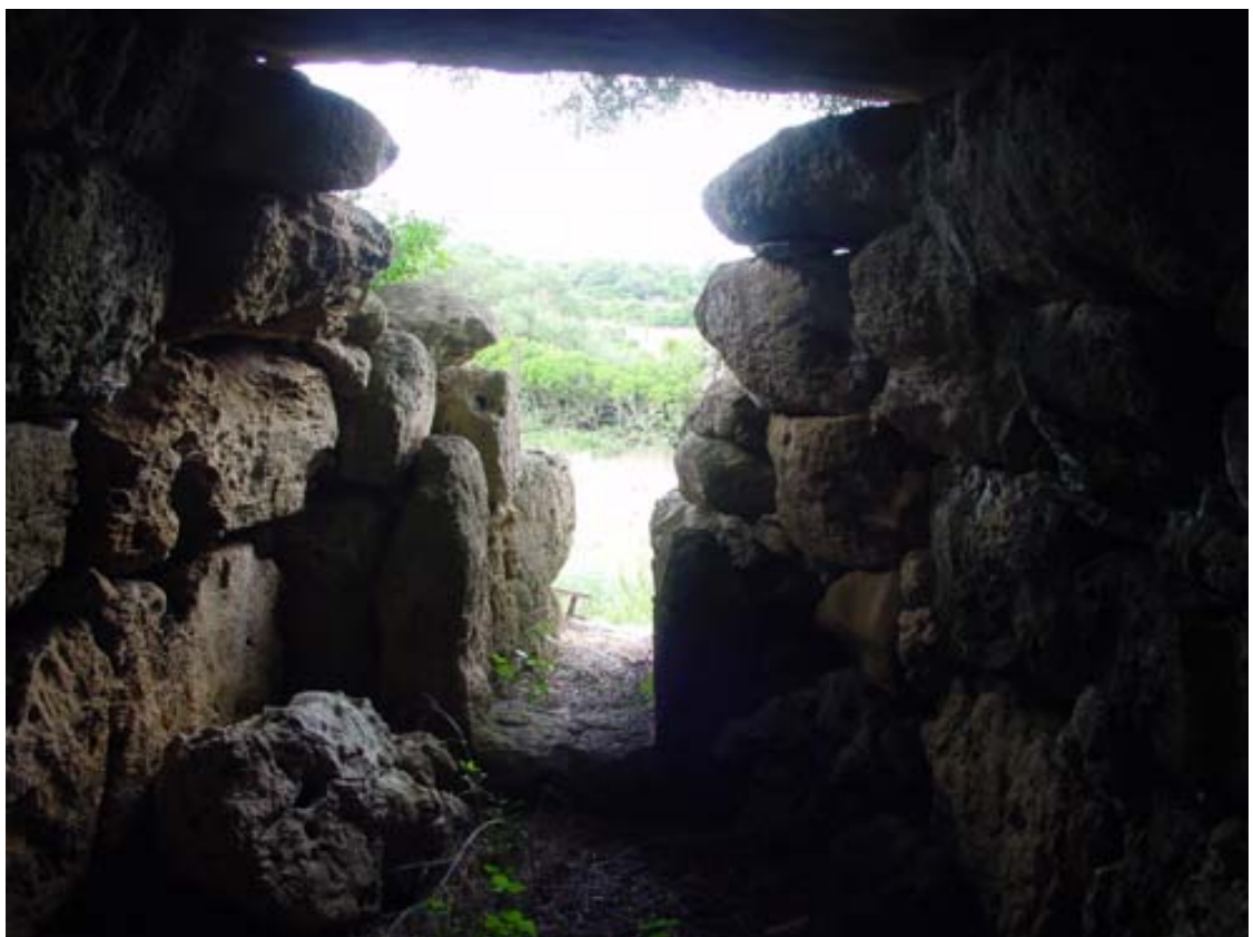
8. Vista del acceso y losa perforada desde el interior
