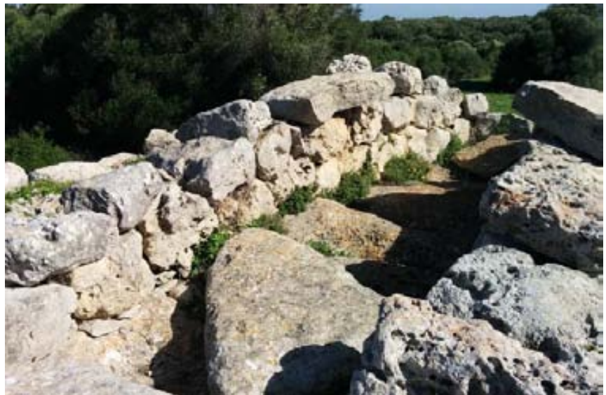
10. Paramento interno de la camara superior de Rafal Rubí Meridional
