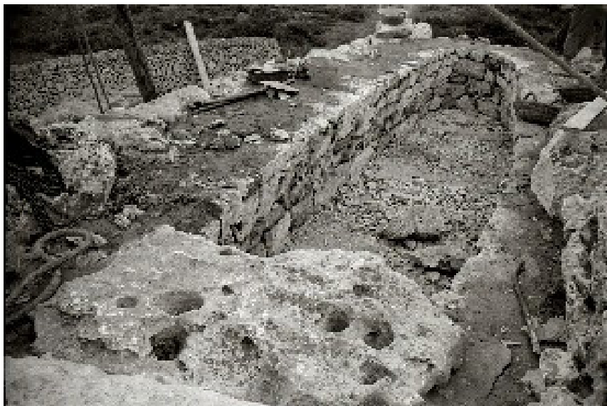
5. Cámara superior de Es Tudons en proceso de restauración
