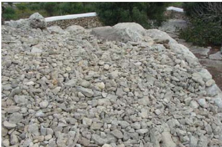
9. Biniac Argentina Oriental. Cubierta de la naveta, con vista del relleno de cascajo
