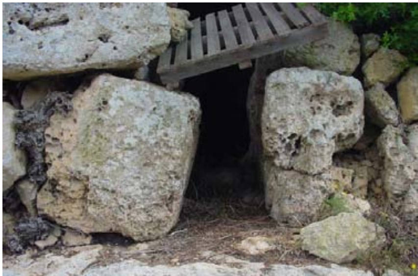
4. Puerta de acceso al corredor de Torralbet
