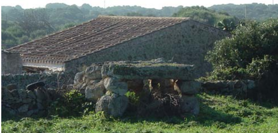
2. La construcción de Cotaina de Can Rabassó
