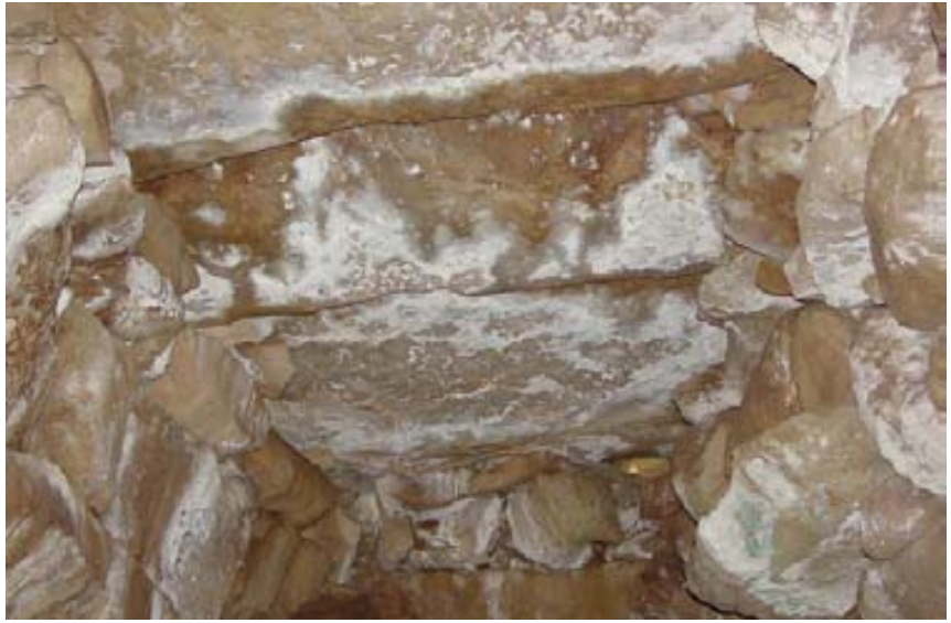
6. Biniac Argentina Oriental . Losas de la cubierta
