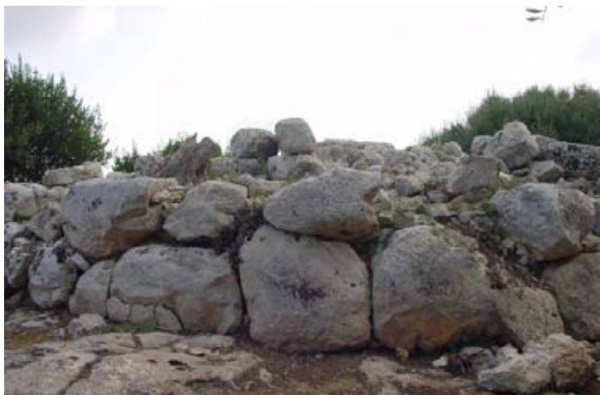
11. Paramento exterior de Bniac Occidental
