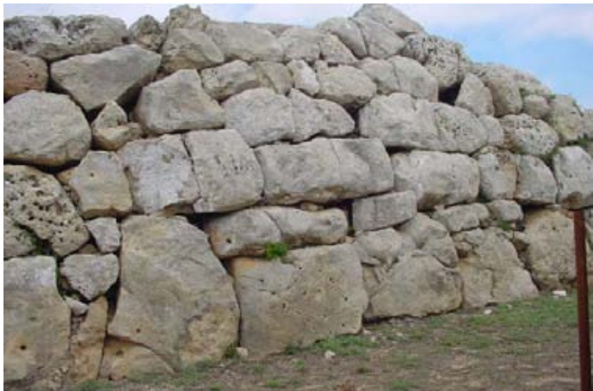
12. Paramento exterior de Rafal Rubí Meridional
