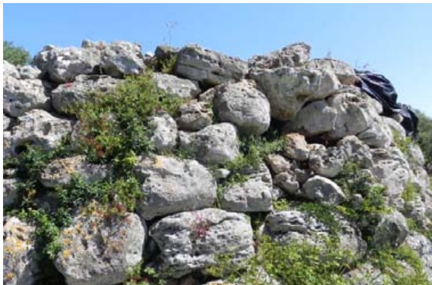
15. Detalle del paramento exterior. Torre Llissà
