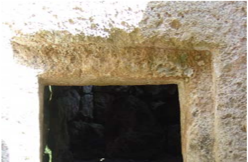
8. Detalle del rebaje de la losa perforada
