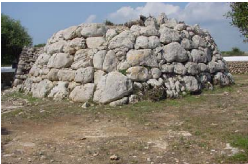
11. Biniac Argentina Oriental. Paramen- to exterior, en el ábside
