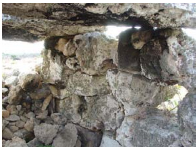
5. Paramento interno de Torre del Ram 1
