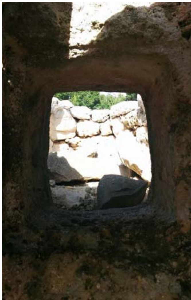
4. Naveta Biniac Occidental. Losa perforada vista desde el ábside
