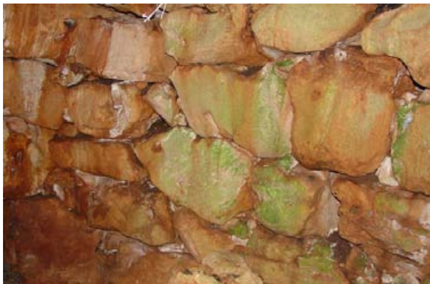
9. Paramento interior de la cámara. Naveta Torre Llissà
