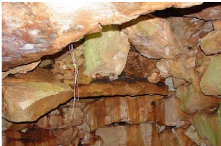
11. Vista de las losas de cubierta por la parte interior de la cámara. Una de las lajas se ha partido y cedido. Torre Llissà
