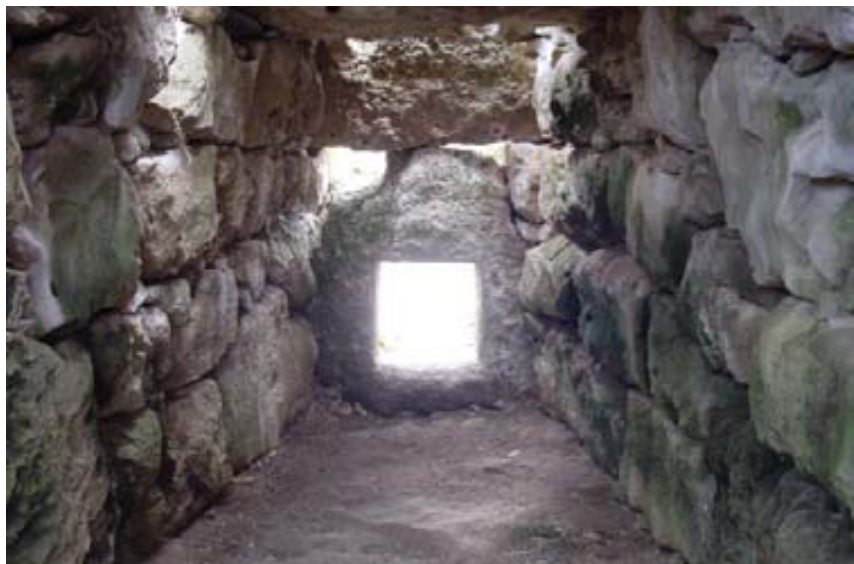
11. Vista de la losa perforada y cámara inferior de Rafal Rubí Septentrional
