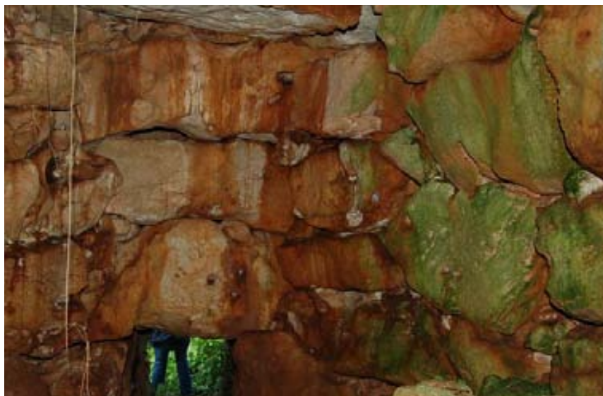
10. Paramento interior y acceso al corredor. Torre Llissà
