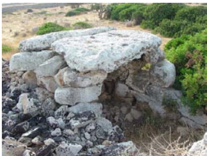
3. Lajas de la cubierta de Sa Torre del Ram
