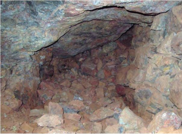
Figura 88.7. Tramo de galería prehistórica cuyo techo muestra formas asociadas a un ataque por fuego.
