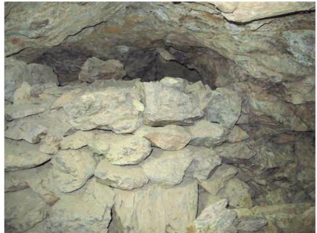
Figura 9.4. Muro de Fortificación de la bóveda de la cámara de la entrada de la labor 3.
