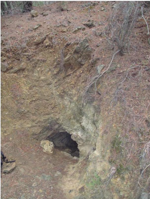
Figura 9.2. Entrada del socavón de la labor 2, parcialmente colmatada y excavada en un frente de cantera. Altura de la boca de 0,5 metros.
