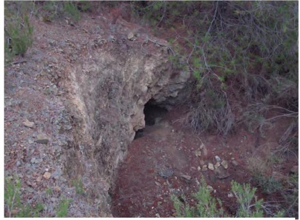
Figura 9.3. Entrada en el frente de cantera de la labor 3. La altura de la boca es de 1,2 metros.
