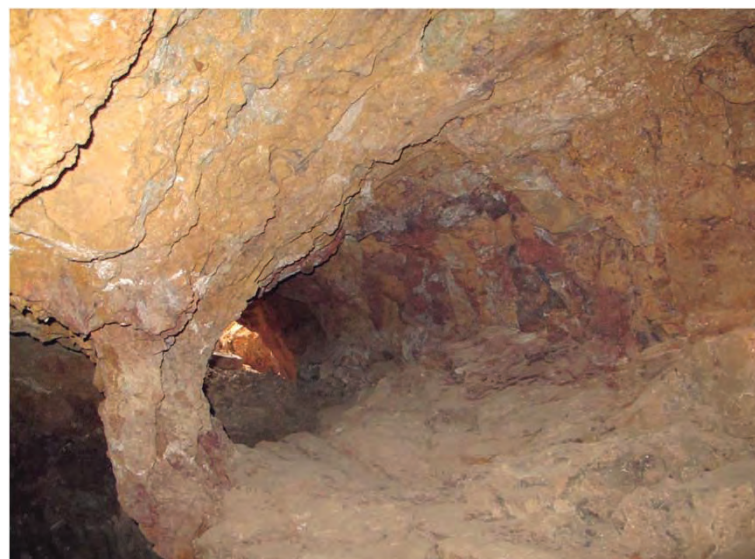
Fig. 67.12. Misma zona que figura 67.10 vista desde el ángulo contrario. Se observa la entrada independiente a la pequeña galería y la fragilidad del pilar que pone en peligro la sustentación de la bóveda.
