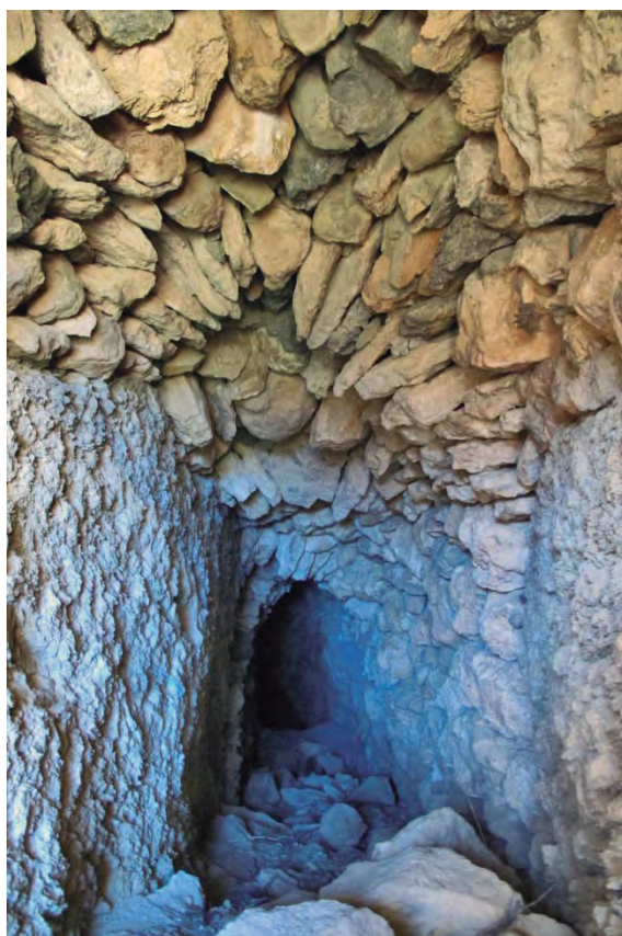
Fig. 69.2. Interior con toda la bóveda mamposteada y algunos tramos laterales.
