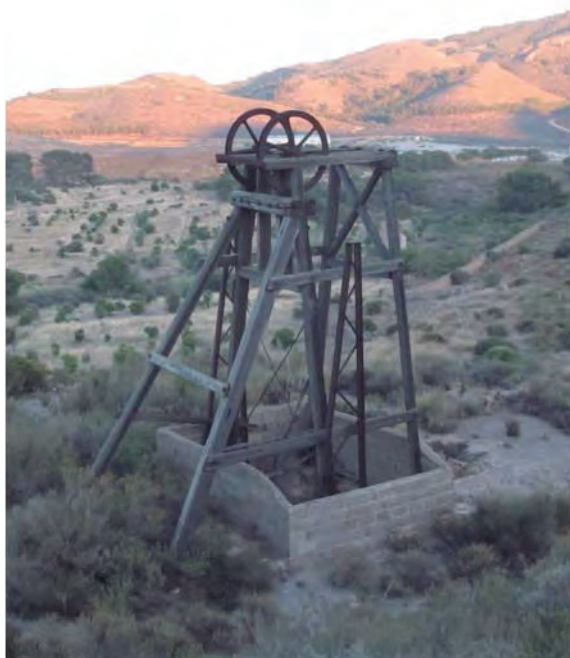
Fig. 79.2. Vista del castillete, en madera, perfectamente conservado.
