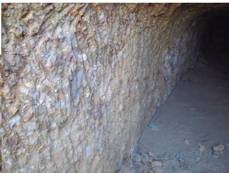
Fig. 68.5. Socavón abierto en la misma cantera, muy regular y también con marcas de picos en todas sus paredes.
