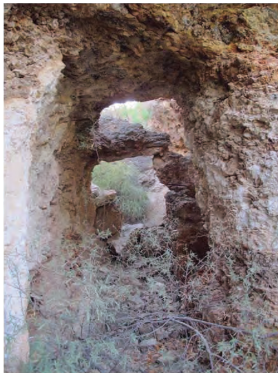
Fig. 54.2. Socavón de entrada a las labores. No se observan bloques caídos del techo en el suelo, por lo que quizás ya era abierta desde que se labró.
