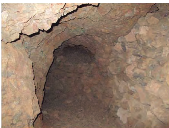
Fig. 65.3. Tramo de galería con muro de fortificación lateral.
