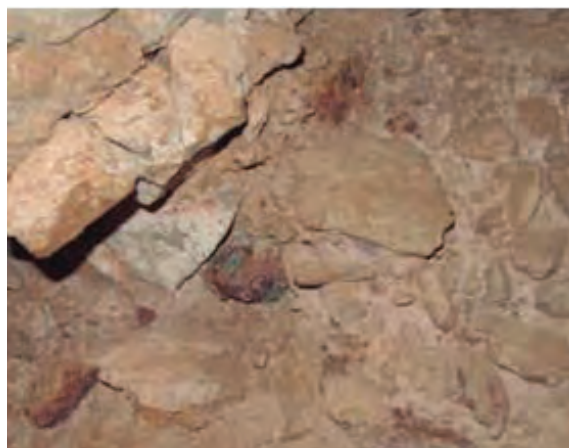
Fig. 79.8. La galería excava un conglomerado carbonatado con relictos de mineralización de cobre.
