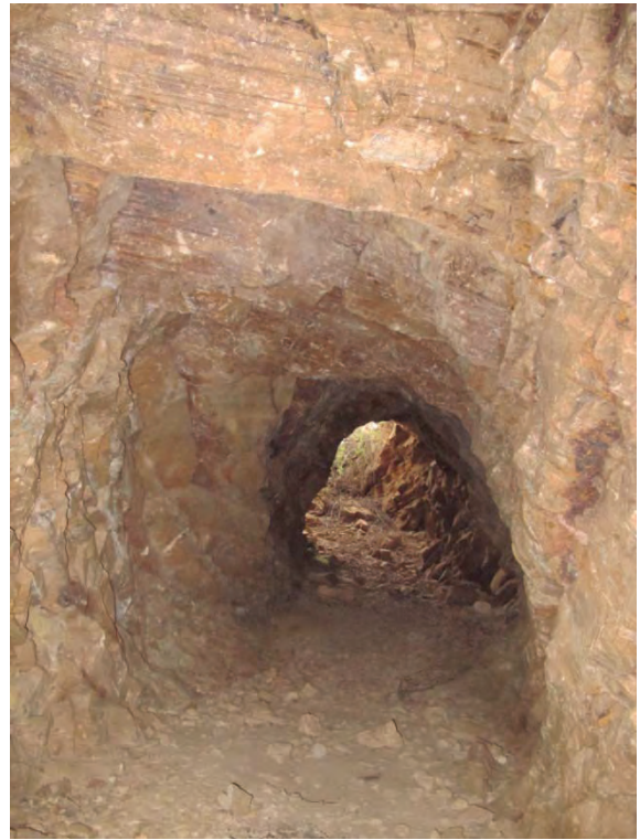
Fig. 67.2. Vista del socavón superior del Indicio 1 desde el fondo. En la imagen no se aprecia la pendiente pero si las calizas de la caja.
