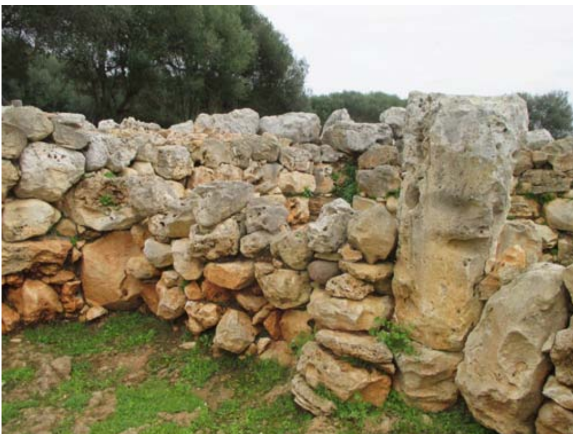
Mur intern que separa les habitacions NE i NO del Cercle 7 de Torre d'en Galmés
