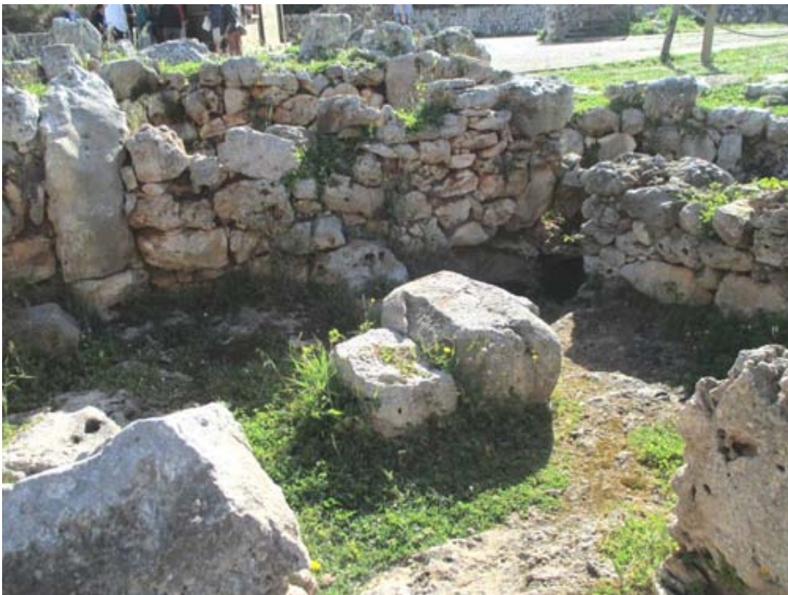
Zona del pati amb cisterna a l'angle SE del Cercle 2 de Torre d'en Galmés
