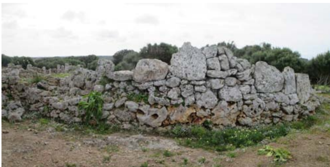
Mur exterior del Monument 3 de So na Caçana
