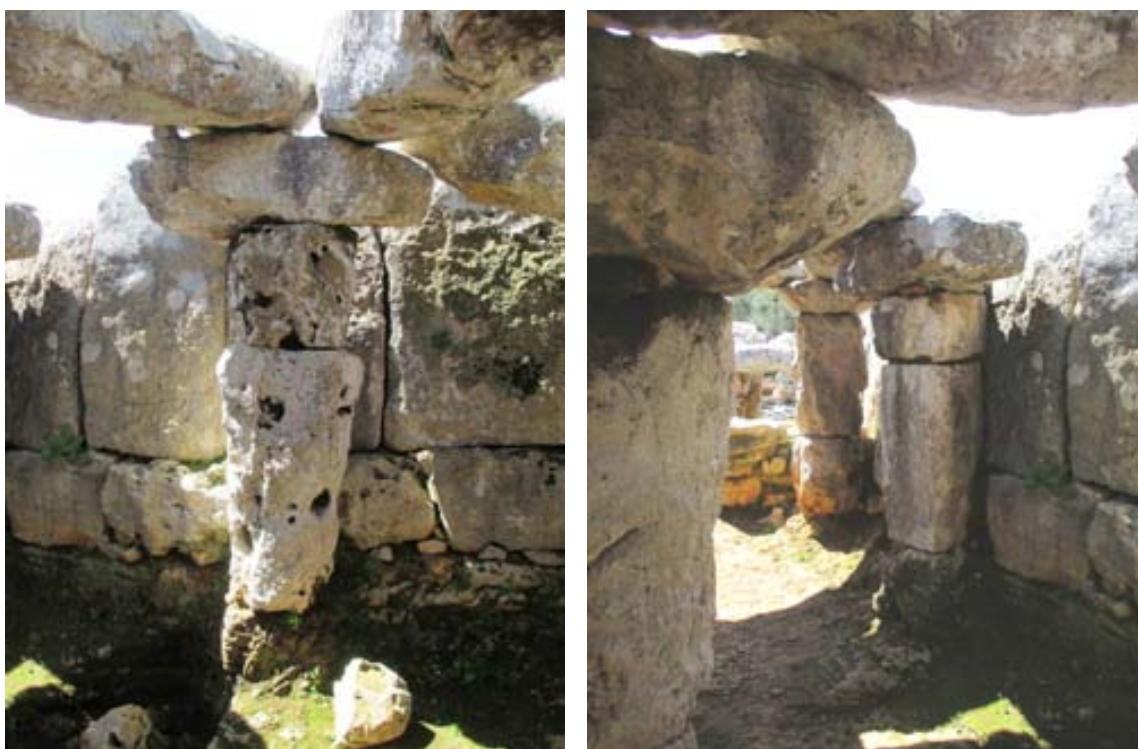
Adossament de pilastres al mur exterior del Cercle 6 de Torre d'en Galmés, per sostenir les lloses de la coberta de la Sala Hipòstila
