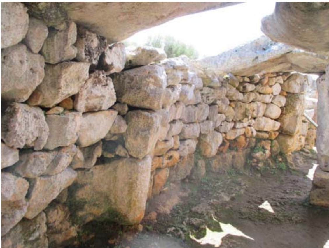
Coberta sobre el mur E de la Sala Hipòstila de Torre d'en Galmés
