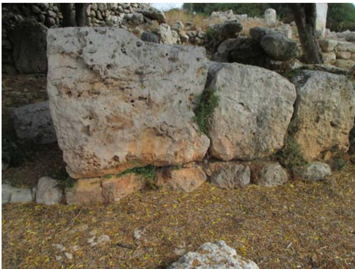
Detall del mur de la façana amb sòcol i bloc de pedra vertical, de la Casa 2 de Sa Torreta de Tramuntana
