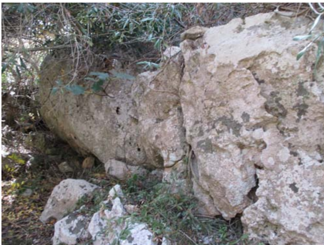
Mur de tancament de la Casa 5 de Sa Torreta de Tramunta, totalment cobert per la vegetació
