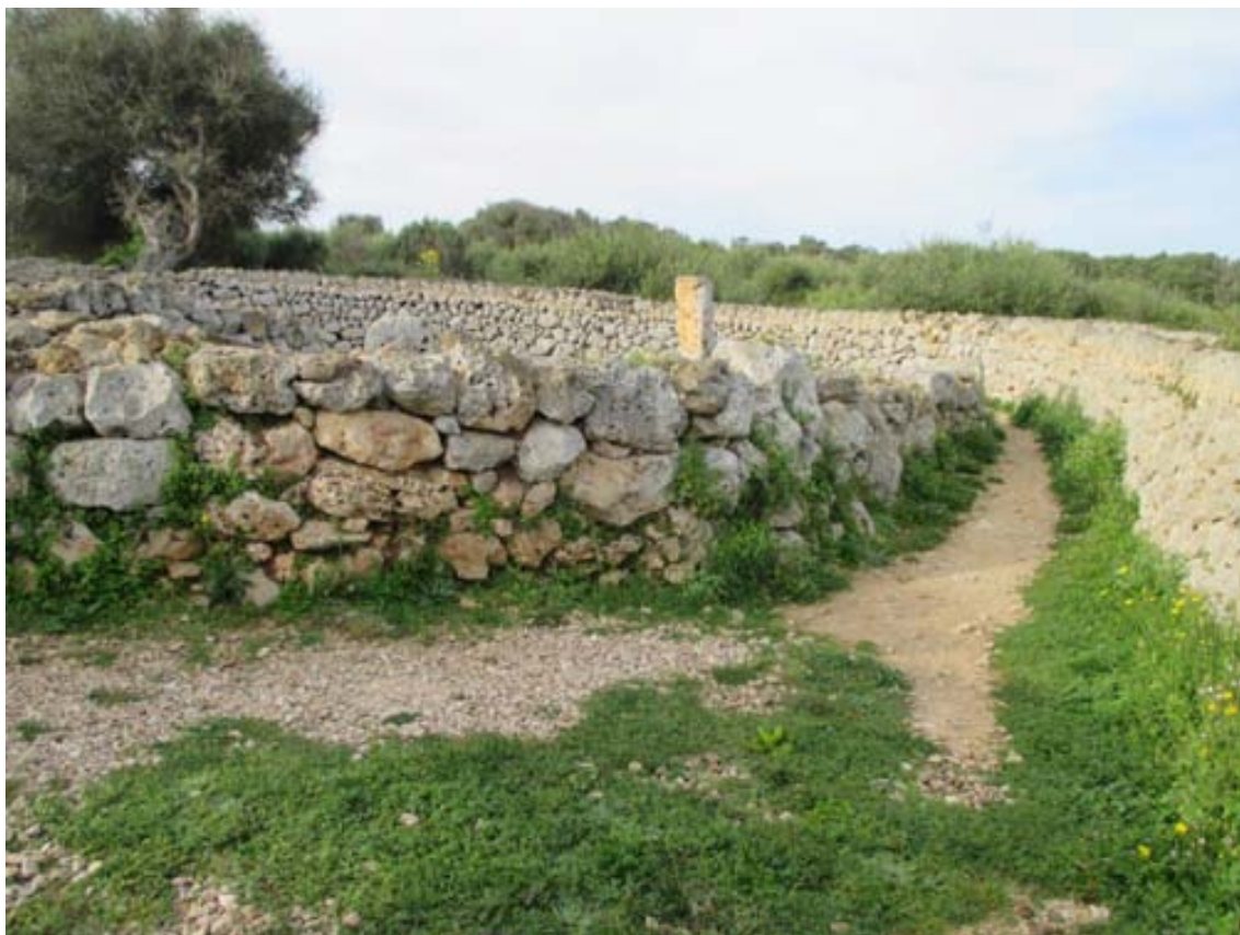
Mur exterior de la Casa 1 (PAC) de Trepucó
