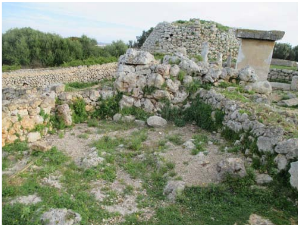
Zona N i E de la Casa 2 (PAC) de Trepucó
