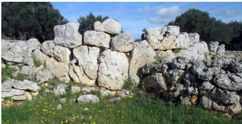
Unió dels murs exterior dels Cercles 2 i 3 de torre d'en Gamés
