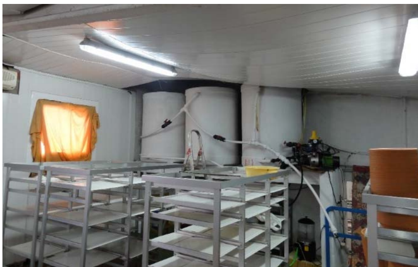
Fotografía 11. Instalación de máquina de agitación conectada a estanques con agua de pozo para realizar la mezcla.
