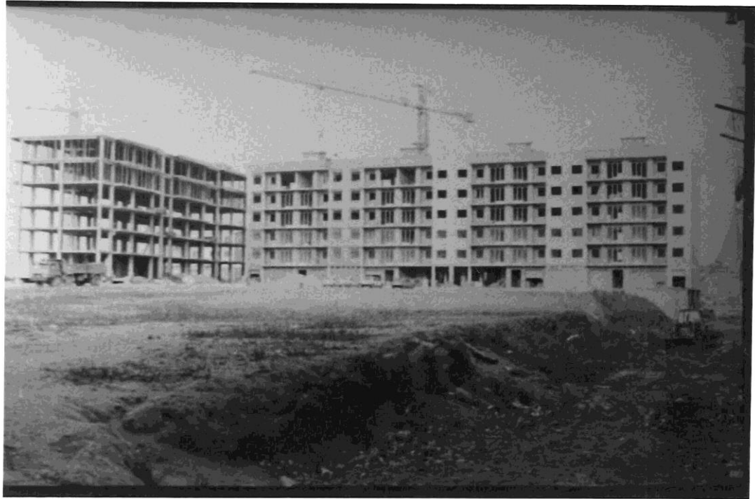
Construcción de los primeros bloques de pisos en la Ciudad Satélite Riera-Marsà. Autor desconocido. AMMV.
