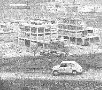
VISTA PARCIAL DEL POLIGONO INDUSTRIAL RIERA - MARSA
