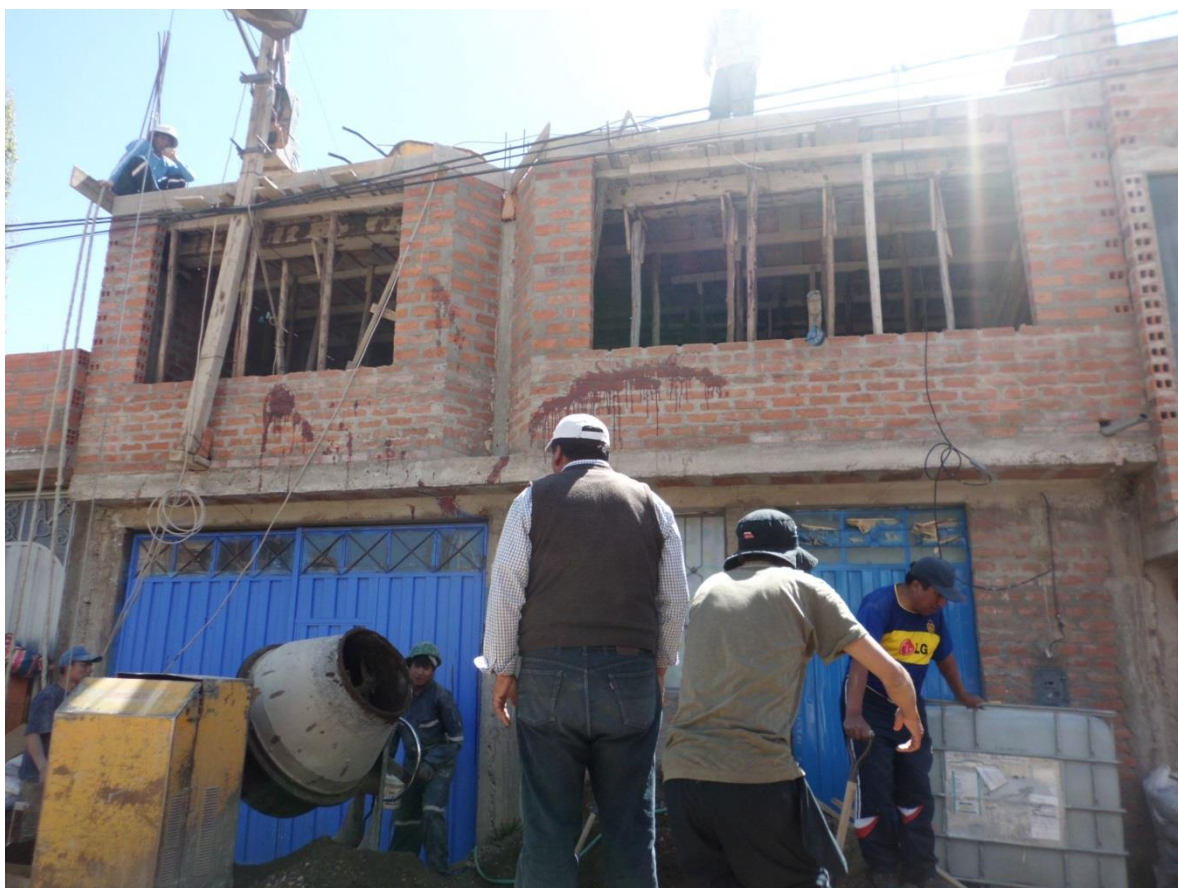
Foto 11: Salcedo, Puno, trabajos para la construcción del techo. En el muro puede notarse la mancha de sangre de la wilancha
