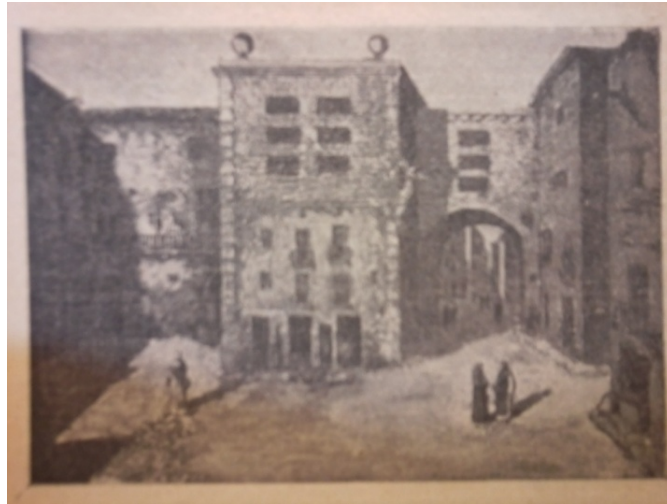
Figura 9.67: Dibuix de la plaça de l'Àngel abans de la demolició de la torre septentrional (a la dreta de la imatge) i de l'arc de la porta NE. (Carreras Candi, s/a, p. 376).
