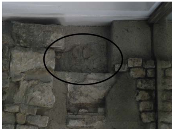
Figura 9.72: Detall de l'alçat NO de la façana de la porta SE, amb la indicació de la posició d'un capitell reutilitzat. (foto A. Ravotto)
