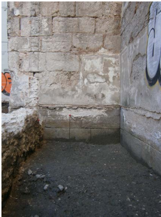
Figura 9.5: Parament de la torre V/5 (torre 28), al carrer Sotstinent Navarro (foto A. Ravotto).
