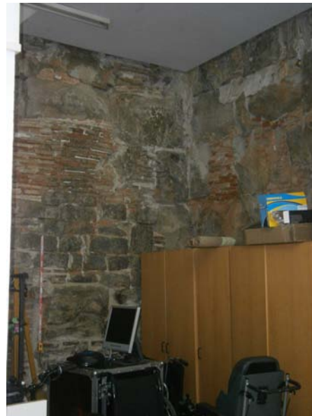
Figura 9.40: Costat N de la torre XIV/2 (torre 67; a la dreta) i arrencament del llenç (a l'esquerra) entre aquesta i la torre XIV/3 (torre 68), a la planta baixa del carrer Banys Nous 16 (foto: A. Ravotto).
