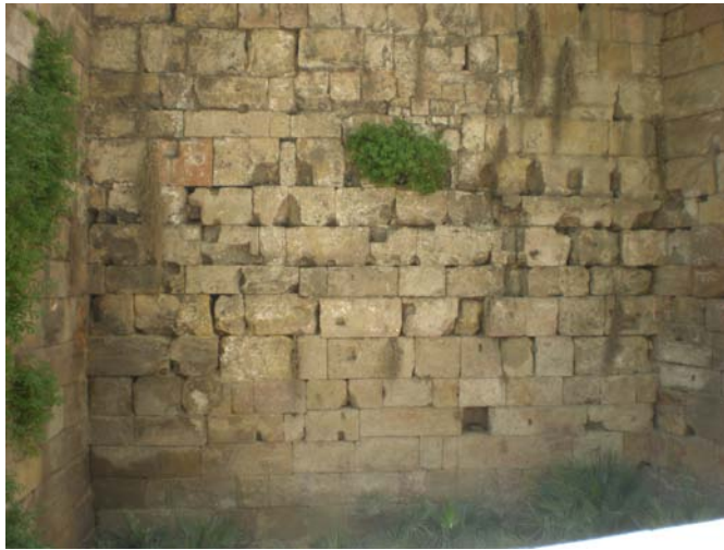
Figura 9.3: Parament de la reforma baix imperial al carrer Sotstinent Navarro (foto: A. Ravotto).
