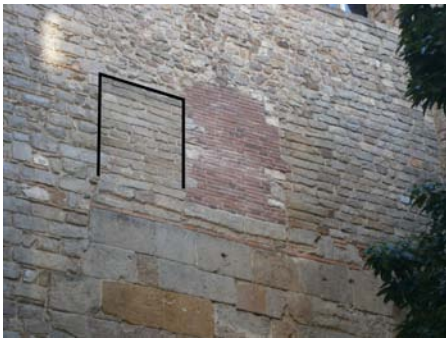
Figura 9.45: Hipotètic merlet localitzat al tram entre les torres II/1 i II/2 (torres 6 i 7 de la numeració tradicional; foto: A. Ravotto).
