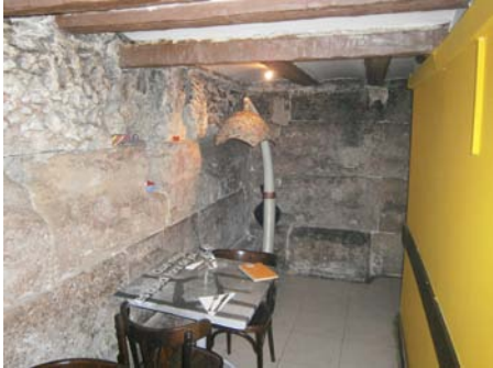
Figura 9.24: Cotes inferiors del costat NO de la torre XI/7 (torre 52 de la numeració tradicional) i llenç entre aquesta i la torre XI/8 (torre 53; foto: A. Ravotto).
