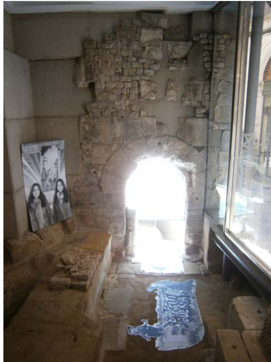
Figura 9.71: Alçat NO - des de l'interior de la ciutat - de la façana de la porta SE (foto A. Ravotto).
