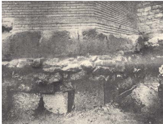
Figura 10.3: Fonaments de la torre II/1 (torre 6; Duran i Sanpere, 1969, fig. 9).
