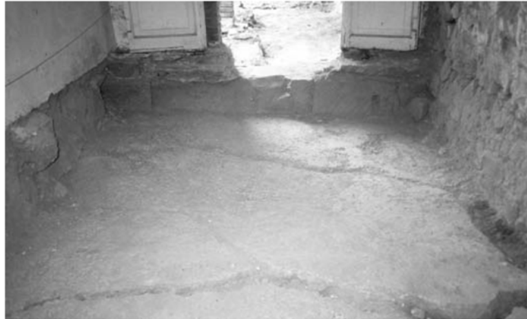
Figura 9.44: Paviment del pas de ronda entre les torres XIII/1 i XIII/2 (torres 61 i 62 de la numeració tradicional), localitzat a l'interior de la finca al carrer de l'Arc de Sant Ramon del Call, 5. Al fons, l'esglaó que permet accedir a la torre XIII/2 (= torre 62; N. Miró i Alaix, 2005, làm. 5).
