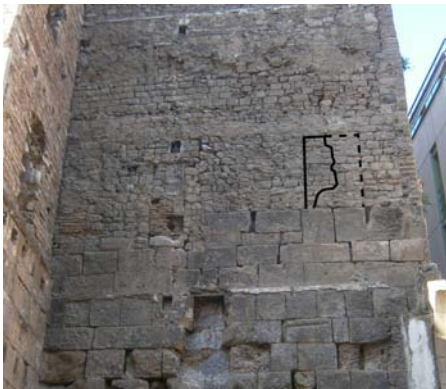
Figura 9.47: Alineació de petits blocs, per sobre del parament de la cortina entre les torres V/3 i V/4 (= torres 26 i 27), que podria correspondre a les restes d'un merlet. També a la banda esquerra de la foto les alineacions del parament deixen suposar l'existència d'un altre merlet, els límits del qual, tanmateix, es confonen amb les refaccions posteriors. (foto: A. Ravotto).
