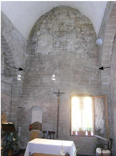
Figura 9.57: Interior de la torre XV/4 (torre 74), façana NO. Amb les fletxes s'indica la filada de parament que sostenia el paviment del segon pis (foto: A. Ravotto).
