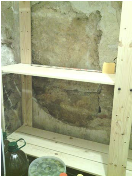
Figura 9.29: Grans carreus visibles a l'interior d'un petit magatzem localitzat entre les finques de carrer Cervantes 3 i carrer d'Avinyó 17 (foto: A. Ravotto).
