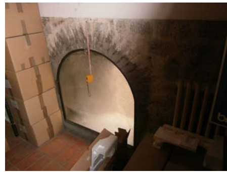
Figura 9.62: Finestra oberta en el mur frontal del segon pis de la torre IV/5 (torre 23; foto A. Ravotto).
