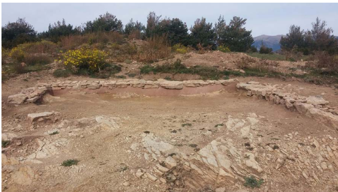
Edifici E al final de la intervenció, després de la seva consolidació
