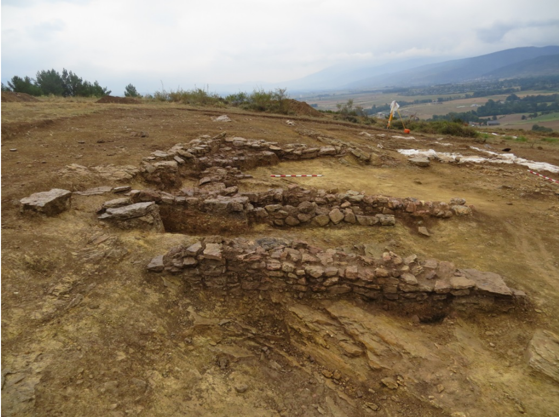
Vista lateral de l'Edifici A, on s'observa, en primer terme, l'habitació de ponent
