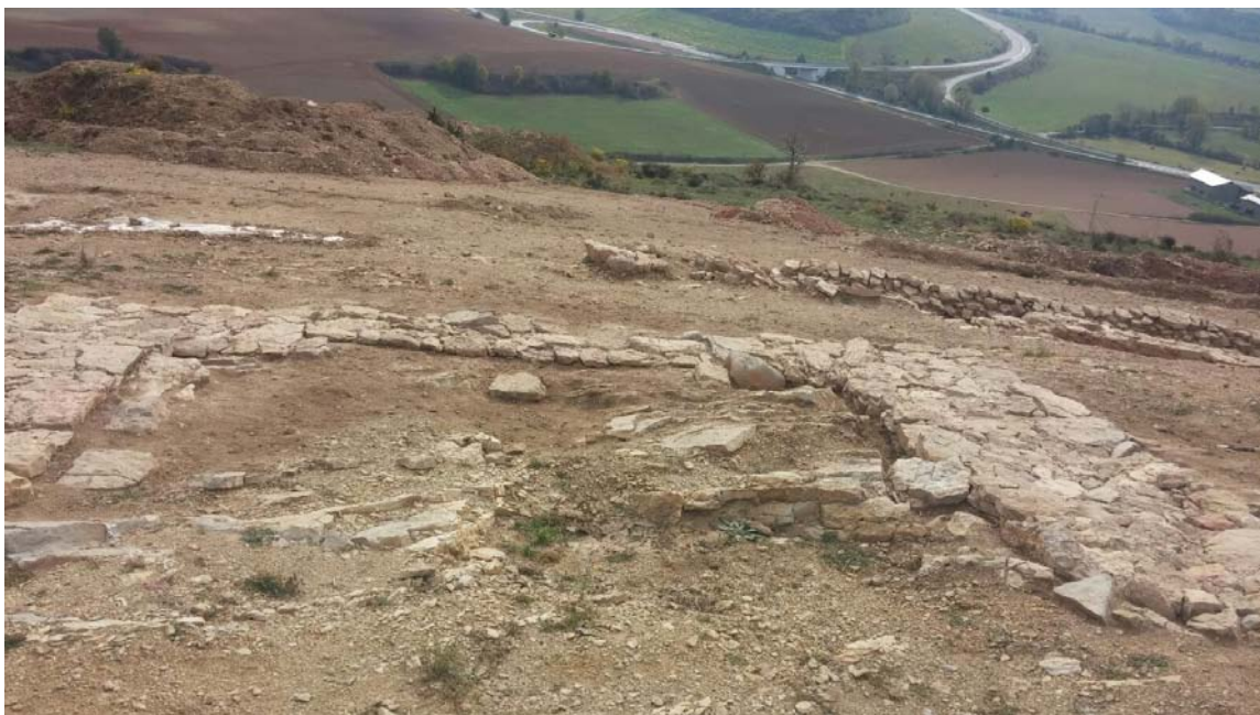
Edifici B vist des de la part superior, on s'observa la possible porta 3069 a la part central
