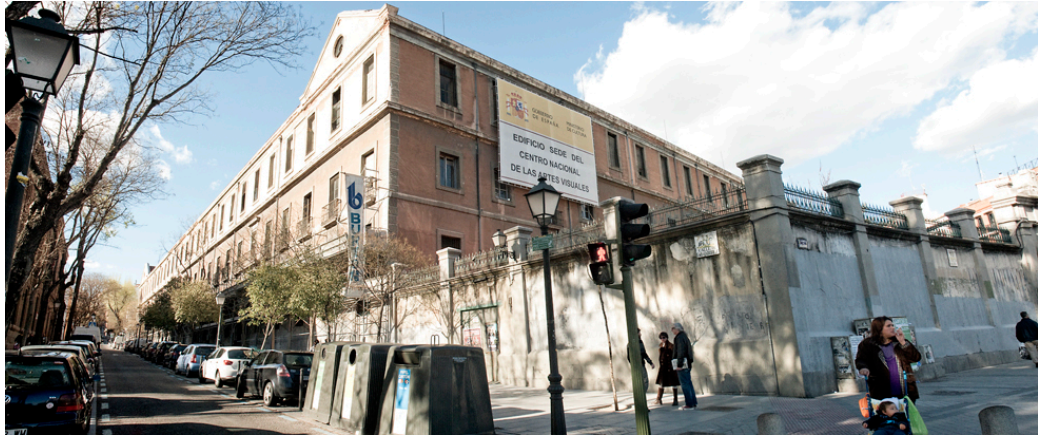
Fig. 1. Imagen del edificio de Tabacalera con un cartel en su fachada anunciando su inminente reconversión en el Centro Nacional de las Artes Visuales (CNAV). Fuente: web del CSAT.
