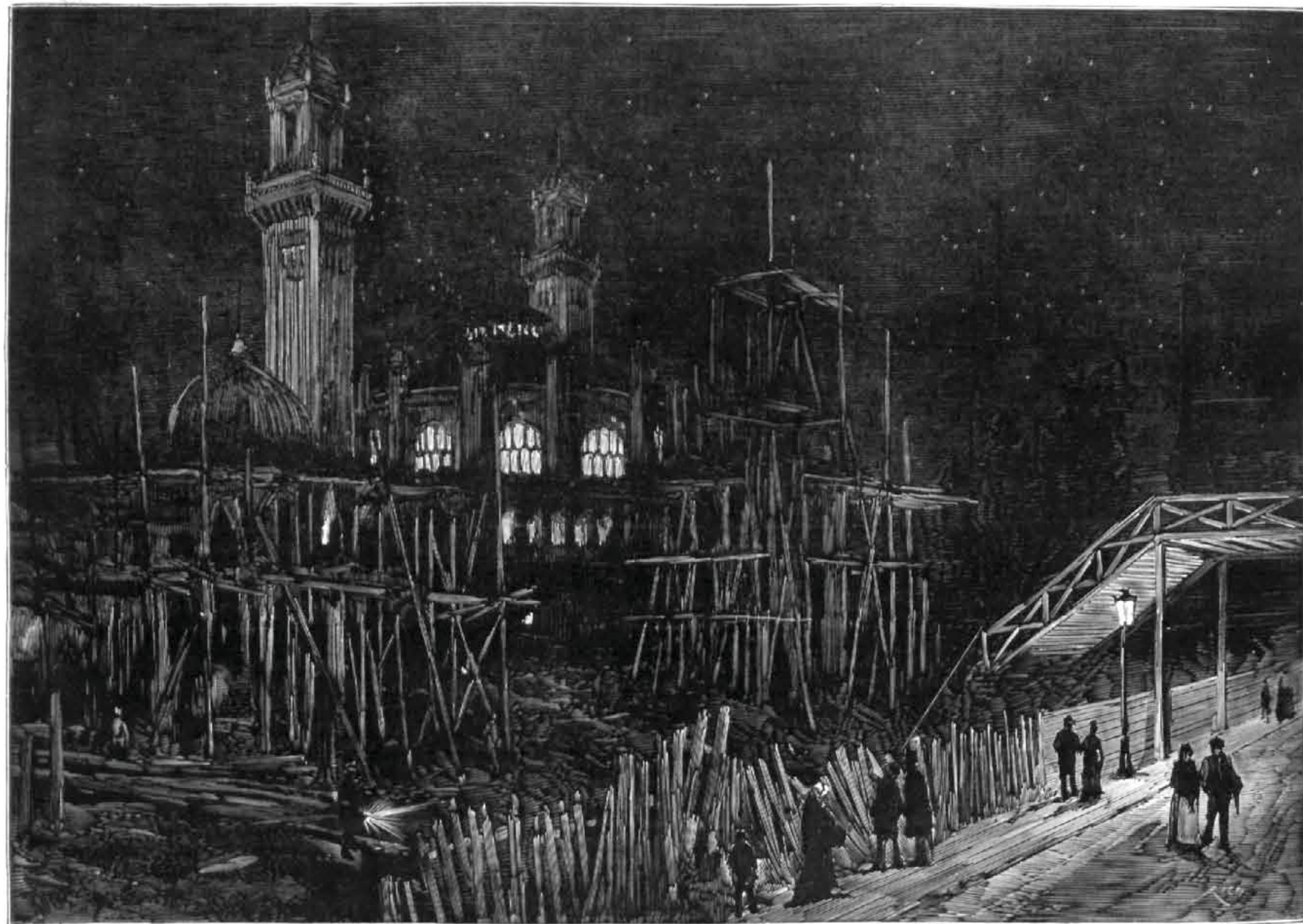
ULTIMOS TRABAJOS EN EL PALACIO DEL TROCADERO, Á FAVOR DE LA LUZ ELÉCTRICA, EN LA NOCHE DEL 30 DE ABRIL.
