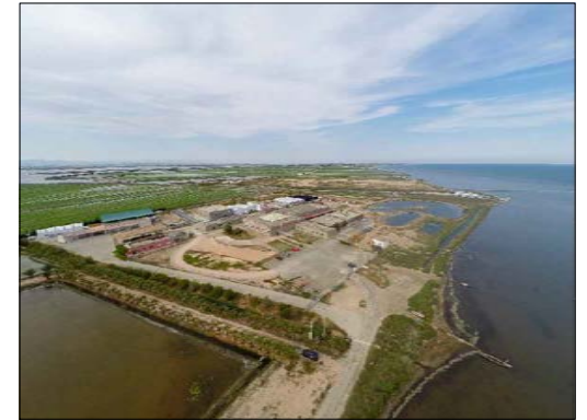
IRTA Sant Carles de la Ràpita Ctra. Poble Nou, km 5,5 (43540 Sant Carles de la Ràpita - Tarragona)
