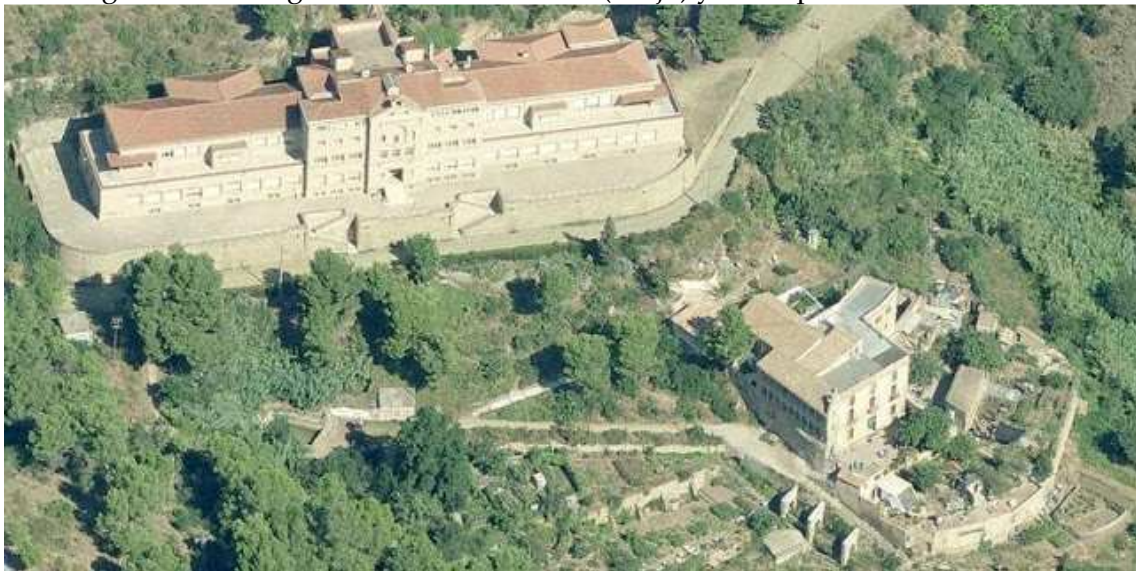
Figura 12. Vista general de Can Masdeu (abajo) y el hospital de Sant Llàtzer
