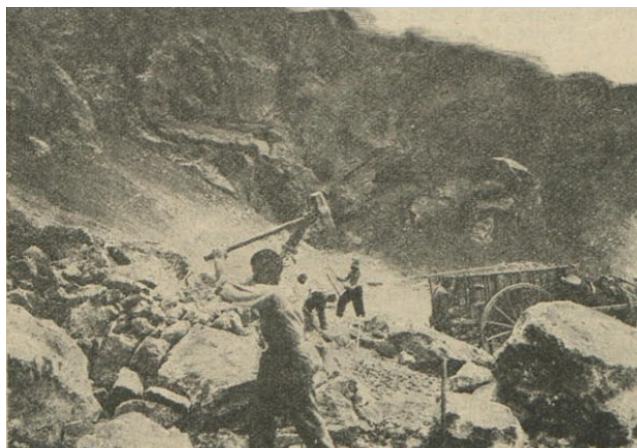
Figures 58 i 59. A l'esquerra, picapedrers treballant en una pedrera on també s'hi veuen carros. A la dreta, un home en l'acció de trencar la pedra amb la maça. Font: ROLDÁN: «Los canteros,» La Ilustración obrera , 29 de setembre de 1904.
