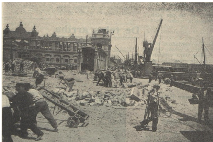
Figura 61. Imatge de treballadors i piles de pedra per a la construcció del port de Barcelona, a càrrec de Fomento de Obras y Construcciones. Font: «Un paseo por el puerto de Barcelona,» La Ilustración obrera , 29 de setembre de 1904.
