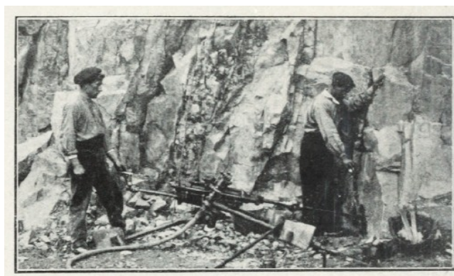
Figures 51 i 52. A l'esquerra, homes amb perforadores d'aire comprimit. A la dreta, grua elèctrica per a moure blocs. Font: La Il·lustració catalana , 4 d'agost de 1912.
