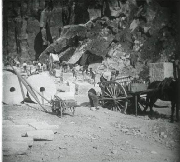
Figures 43 i 44. Homes treballant en una pedrera: a l'esquerra, se'ls veu en l'acció de desbastar la pedra per donar forma a una mola; a la dreta, en el moment de carregar les moles en carros. Autor: Emili Ullés i Daura. Font: AFCEC.
