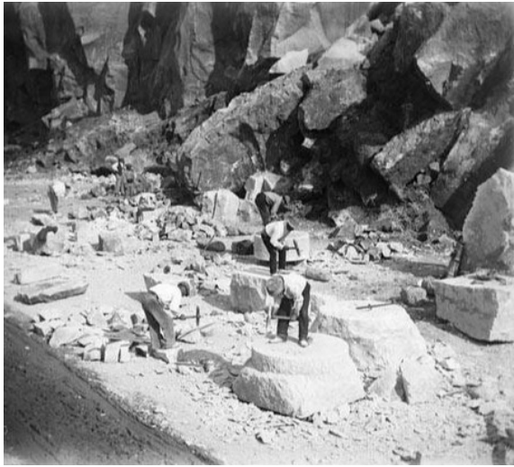
Figures 43 i 44. Homes treballant en una pedrera: a l'esquerra, se'ls veu en l'acció de desbastar la pedra per donar forma a una mola; a la dreta, en el moment de carregar les moles en carros. Autor: Emili Ullés i Daura. Font: AFCEC.
