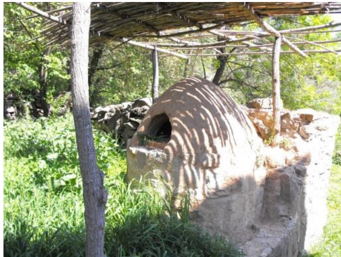
Ilustración 21. Comunidades intencionales ecológicas. Horno de leña exterior de auto-construcción
