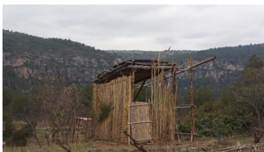
Ilustración 12. Baño seco de auto-construcción en una CIE transformadora de formación.
