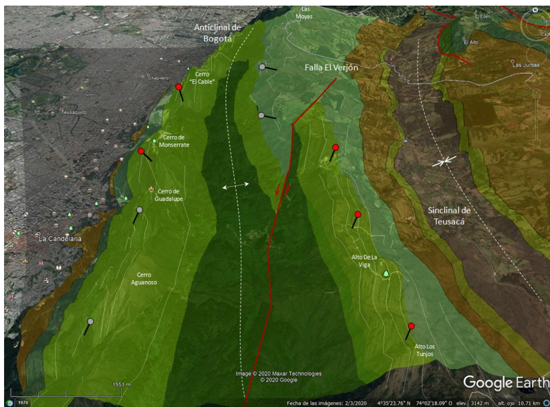
Figura 4.3. Componente de rumbo de la Falla El Verjón sobre el anticlinal de Bogotá en los Cerros Orientales.
