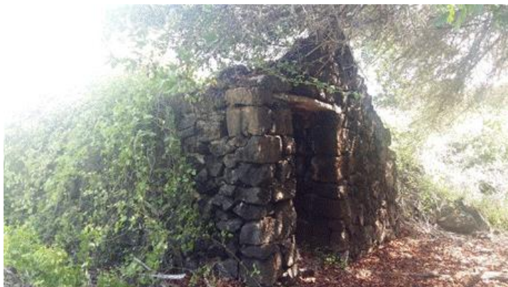
Figura 4.38.- Vista lateral de la casa Graffer
