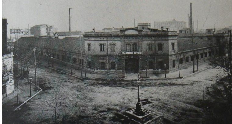
Fig. 3: Fàbrica Francisco Rivièr , Sant Martí de Provençals, Barcelona. Autoria desconeguda, 1913. Rivièr, F. L., Francisco Rivièr 1835-1911 , Exemplar ciclostilat. Barcelona, 1959. p. 112-113, làmina sense numerar.
