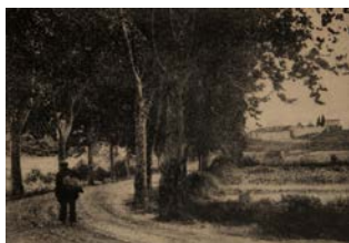
Imagen 382 - Butll. AFC 08/33. Carles M a de Quintana. Carretera de Lloret.
