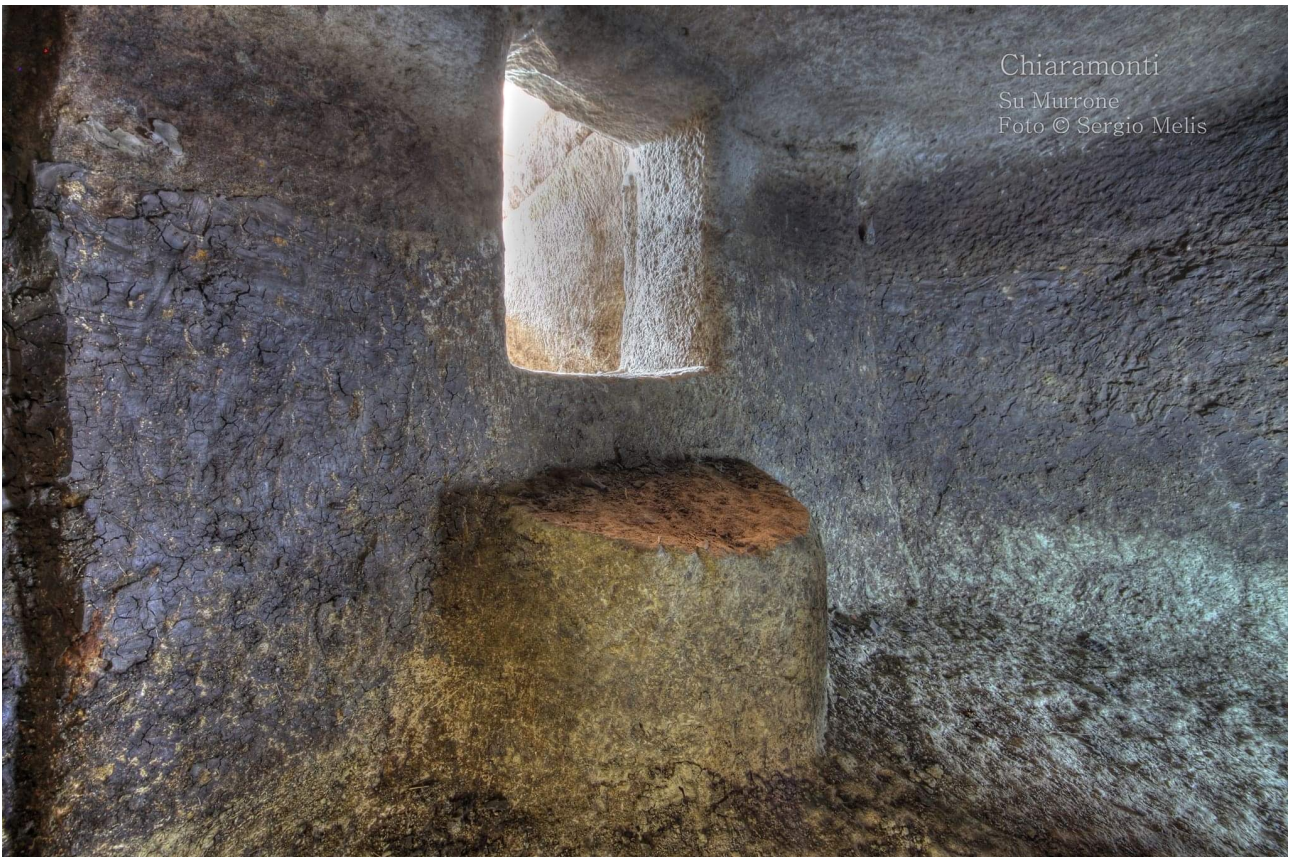
Figura 6.9 – interno della cella 1 con il gradino di forma semicircolare.
