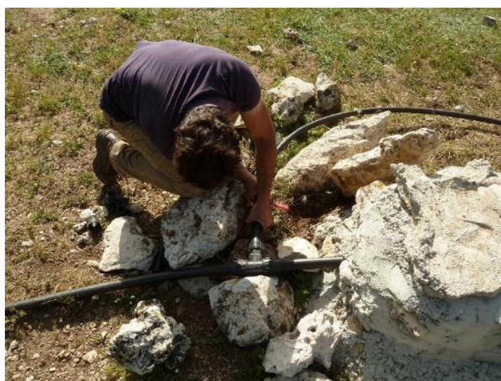
Fotografías 12.1: Infraestructura hidráulica de la zona de pastos de Santiago-Pontones. Un abrevadero (imagen superior) donde beben los animales y balsa de captación y almacenamiento de agua de lluvia (segunda imagen). Finalmente, un pastor reparando un tramo de paso de agua.
