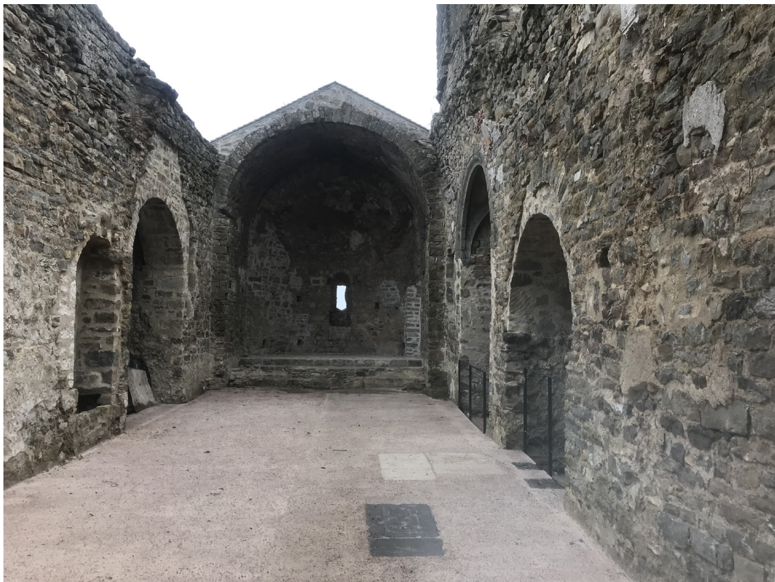
Figura 4.1.2.1 | Imatge de la nau un cop excavada i restaurada. Imatge: ATICS SL.
