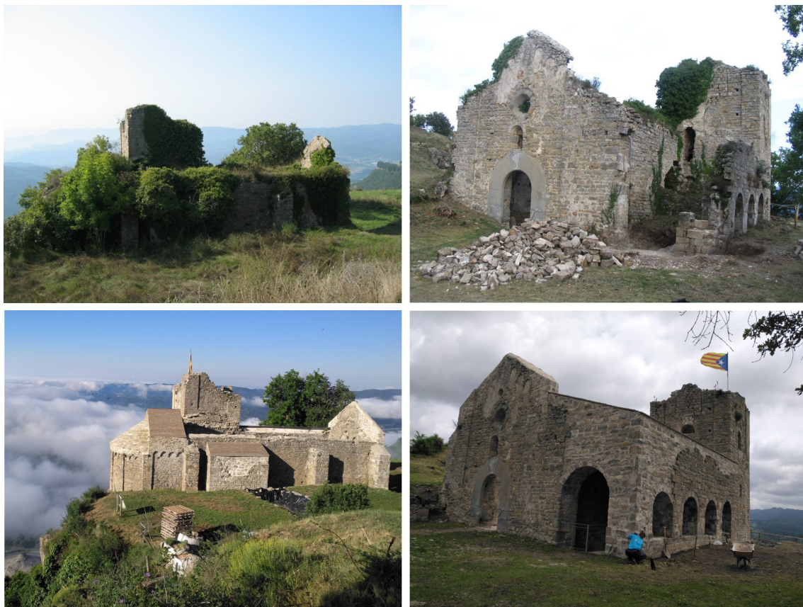
Figura 1.3.4.3 | Imatges de la restauració de l'església, a les fotografies de dalt es pot veure l'estat de l'edifici l'any 2006 i a baix la restauració acabada l'any 2021. Imatge: ATICS SL.
