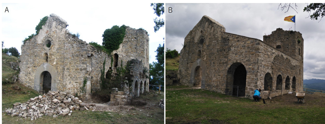
Figura 4.3.1 | Imatges de l'atri de l'antiga església de Santa Maria de Besora. A) inici del buidatge de runa el 2006; B) Restauració finalitzada el 2021. Imatge: ATICS SL.
