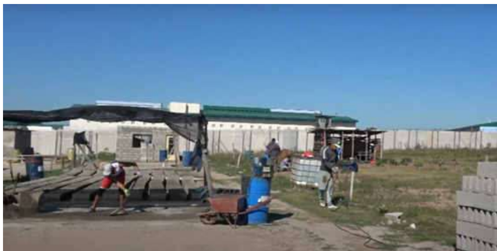
Figura 23: Una de las bloqueras de la Unidad y sus trabajadores
