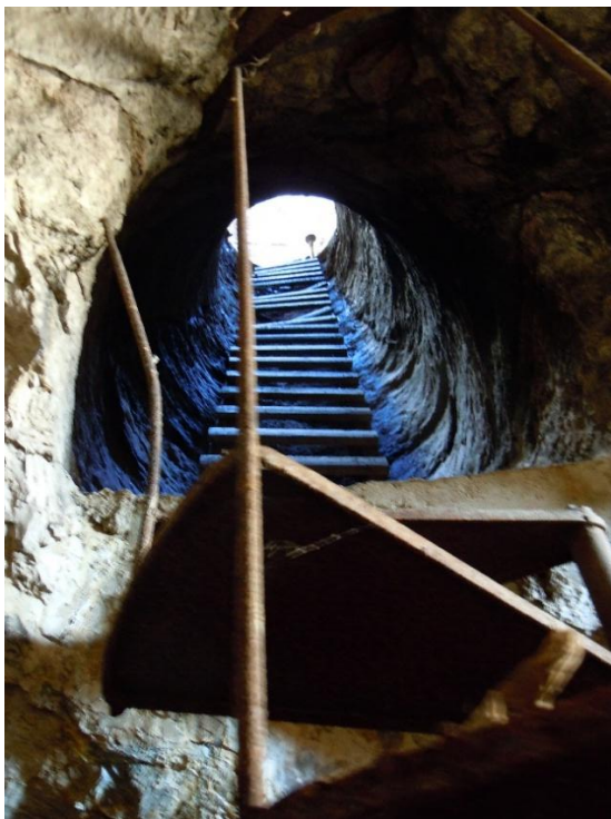
Fig.169. Interior de la torre con escalera de acceso a su parte superior. (Foto del arquitecto BRUNO LA MELA, 2015).
