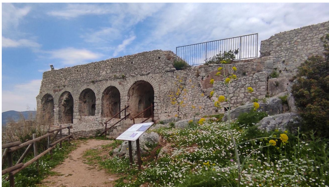
Fig.29. Criptopórtico del Pequeño Templo. (Archivo fotográfico de la FONDAZIONE CITTÀ DI TERRACINA, 2025).
