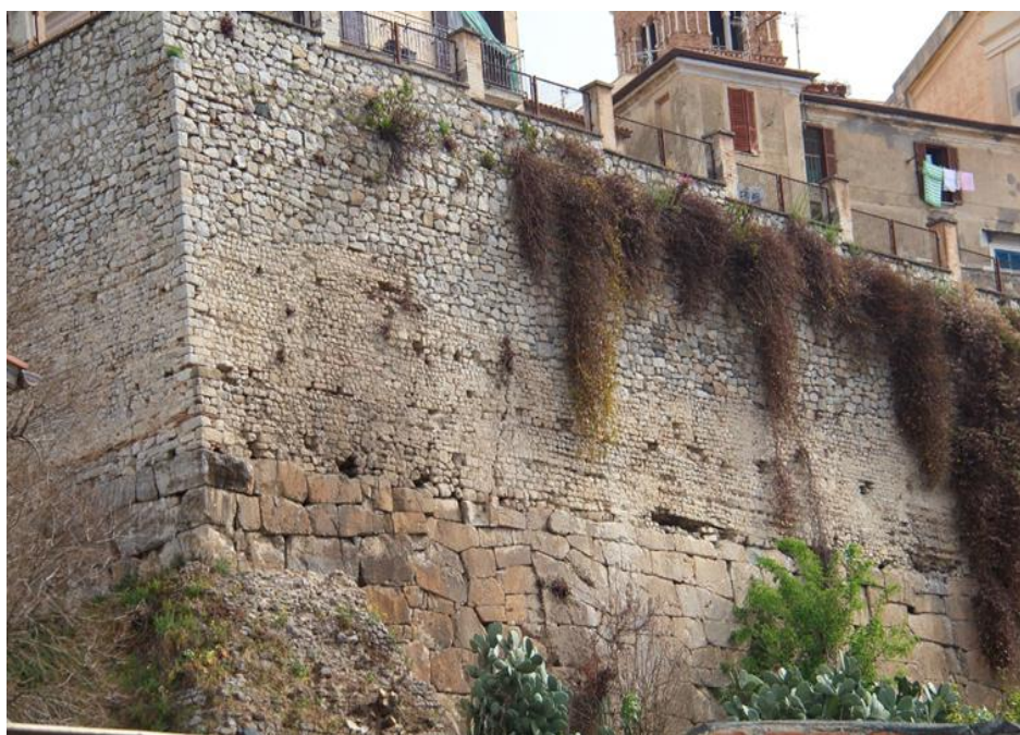
Fig.6. Lado occidental de las murallas en la zona de Posterula , Terracina 67 . La parte superior revela la restauración de épocas sucesivas, en bloques de piedra y ladrillos, pertenecientes al VI sec. d.C.
