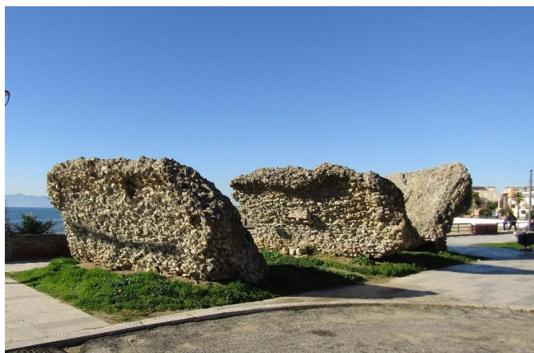
Fig.185. Restos de bóvedas pertenecientes a antiguos almacenes ( horrea ). (Foto de R. VENTORUZZO, 2025).
