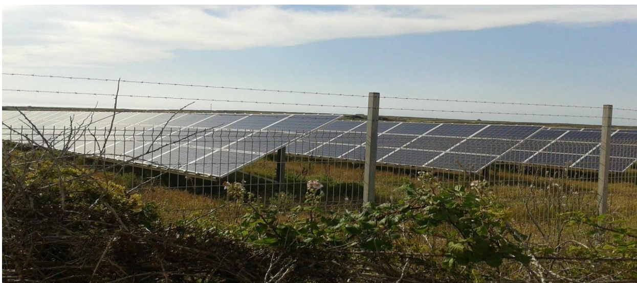
Imatge 14. Parc solar fotovoltaic de Son Salomó a Ciutadella
