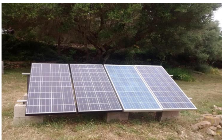
Imatge 27. Panells solars per a l'autoconsum en un nucli rural sense connexió a la xarxa. BioErs
