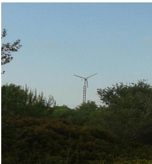
Imatge 20. Petita instal·lació eòlica. BioErs
