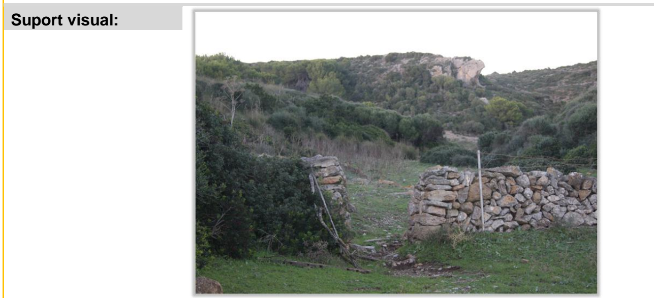
Mur de pedra seca
