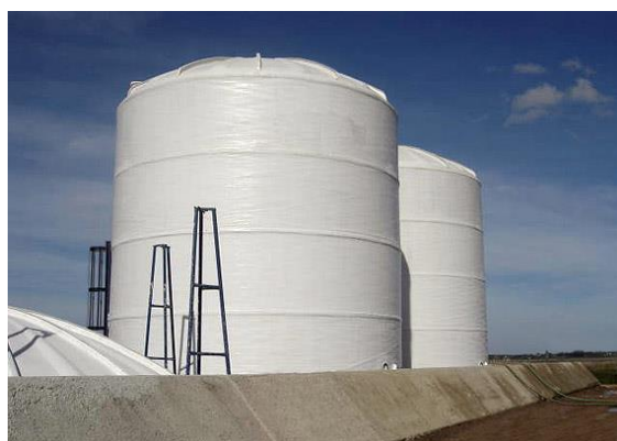
Figura 2.2. Tanques de almacenamiento torisféricos y de fondo plano
