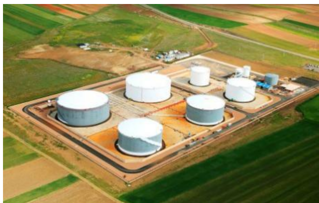
Figura 2.4. Parque de distribución de los tanques de almacenamiento
