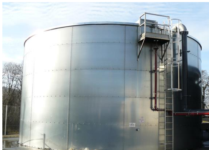
Figura 61.10.12 Depósito de almacenamiento de agua contra incendios de la empresa Prefire
