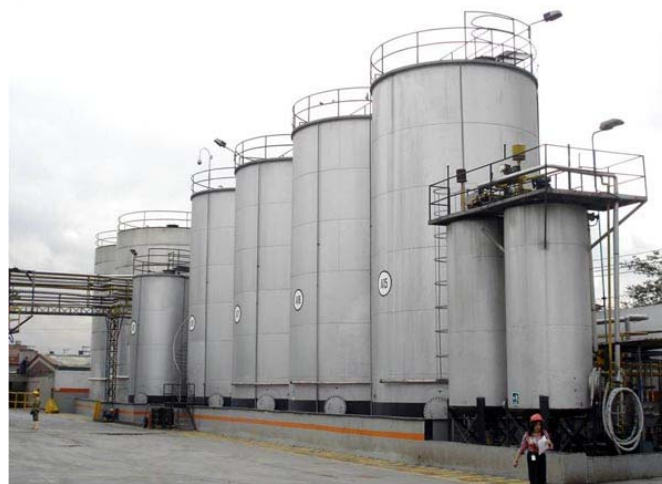
Figura 2.1 Exemple de tancs atmosfèrics
