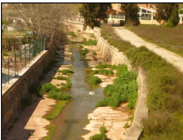
Figura 5.19 Punt d'estudi 03 canalització de la llera
