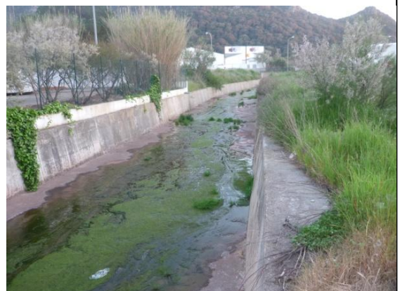
Inici canalització amb una làmina d'aigua i gran quantitat d'algues
