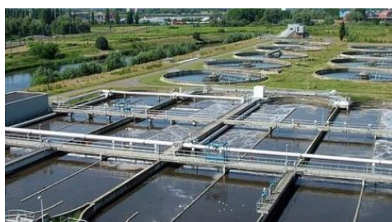
Depuradora del municipi de Ferreries (sedimentació i decantació primària)
