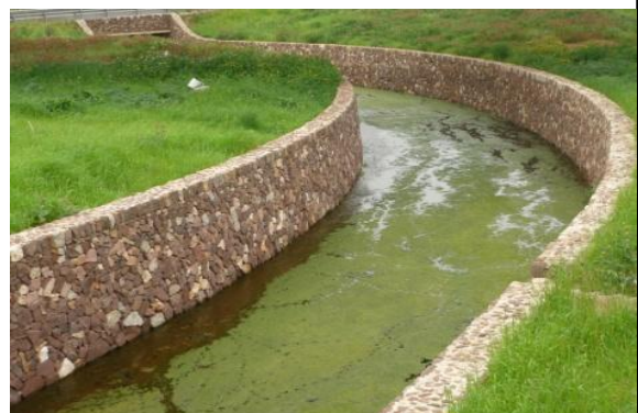
Inici canalització amb una làmina d'aigua i gran quantitat d'algues
