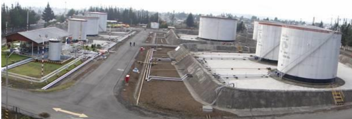
Figura 4: Cubeto de retención en tanques a presión
