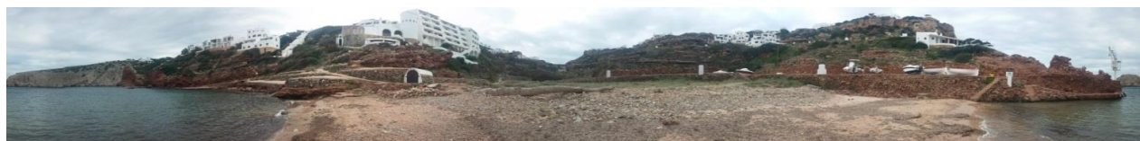
Panoràmica de Cala Morell en el punt de visualització d'infraestructures
