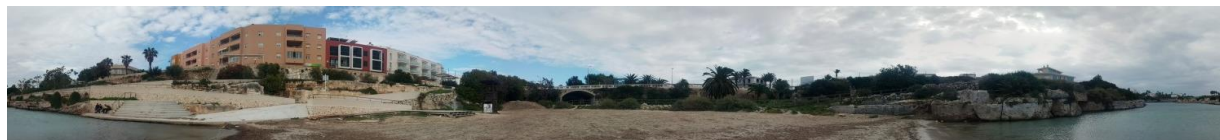
Panoràmica de Cala d'Es Degollador en el punt de visualització d'infraestructures
