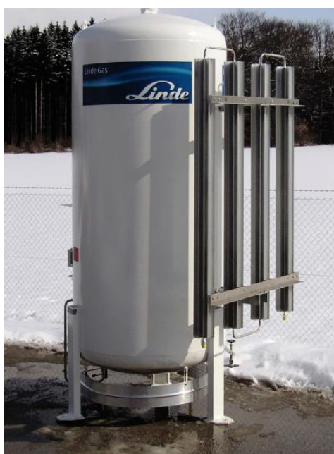
Figura 1.7.1.7-b: Tanque criogénico LINDE
