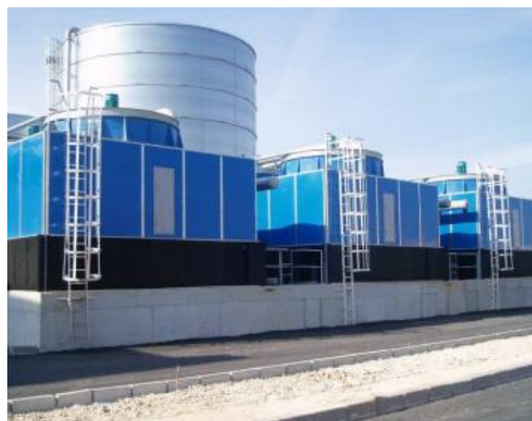
Figura 1.7.1.4-a: Torre refrigeración de la casa EWK
