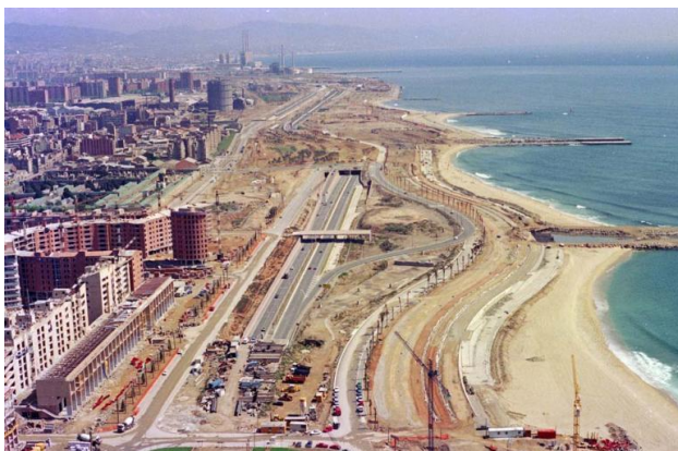
Figura 23. La Vila Olímpica en construcció. (1986).
