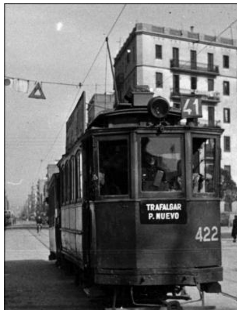
Figura 13. Tramvia que feia la ruta de la línia 41. Font: AHPN
