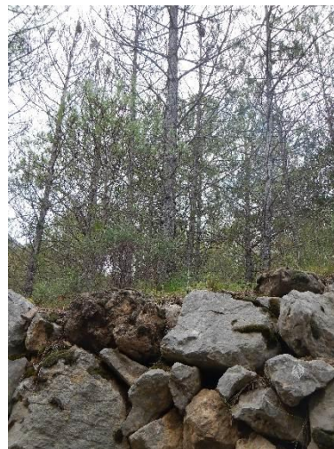
Figura 38: Detall d'un mur de pedra seca de la zona 2. Font: Elaboració pròpia.
