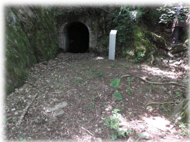
Figura 7. 25 Imatges galeria inferior
