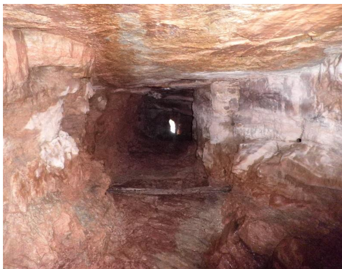
Figura 7. 4 Pou de ventilació galeria inferior
