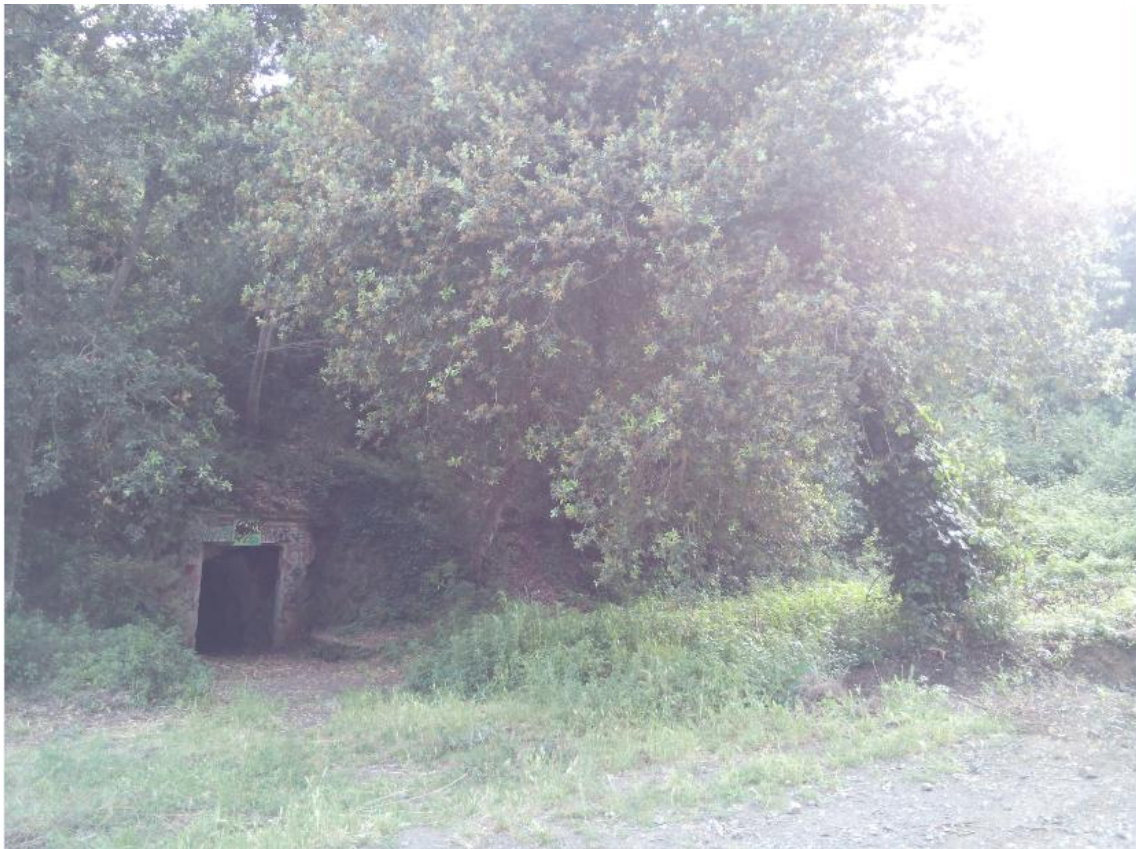
Figura 40. Entrada de la galeria 4.
