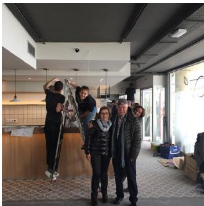
Il·lustració 16 - Ca la Nuri en procés d'obres
