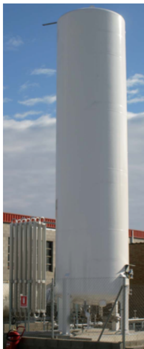
Figura 16. Tanque criogénico de nitrógeno modelo LCC 32V.
