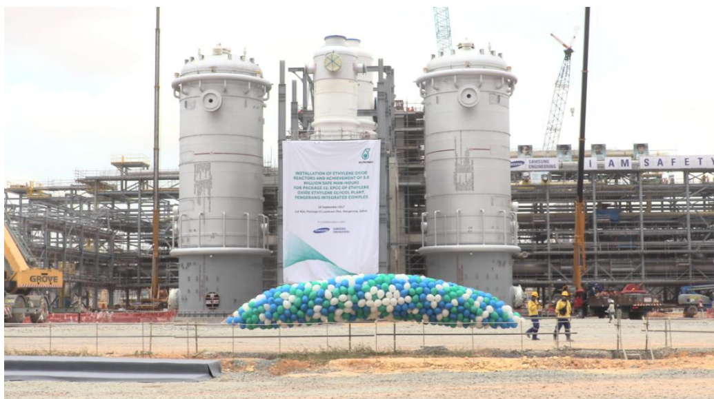
Figura 2.2.2 Reactores de óxido de etileno de la empresa PETRONAS, en Kuala Lumpur, con un diámetro de 7.4m y 25.5 de altura.
