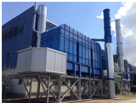
Figura 6: Sistema de oxidació tèrmica regenerativa [13].
